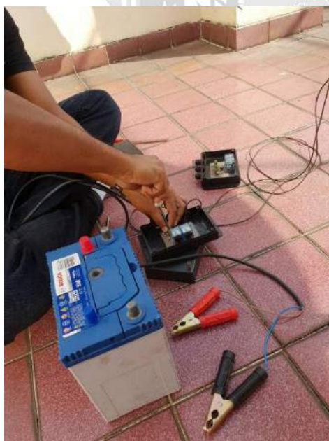
รูปที่ 3.16 การติดตั้งกล่องชุดควบคุม
