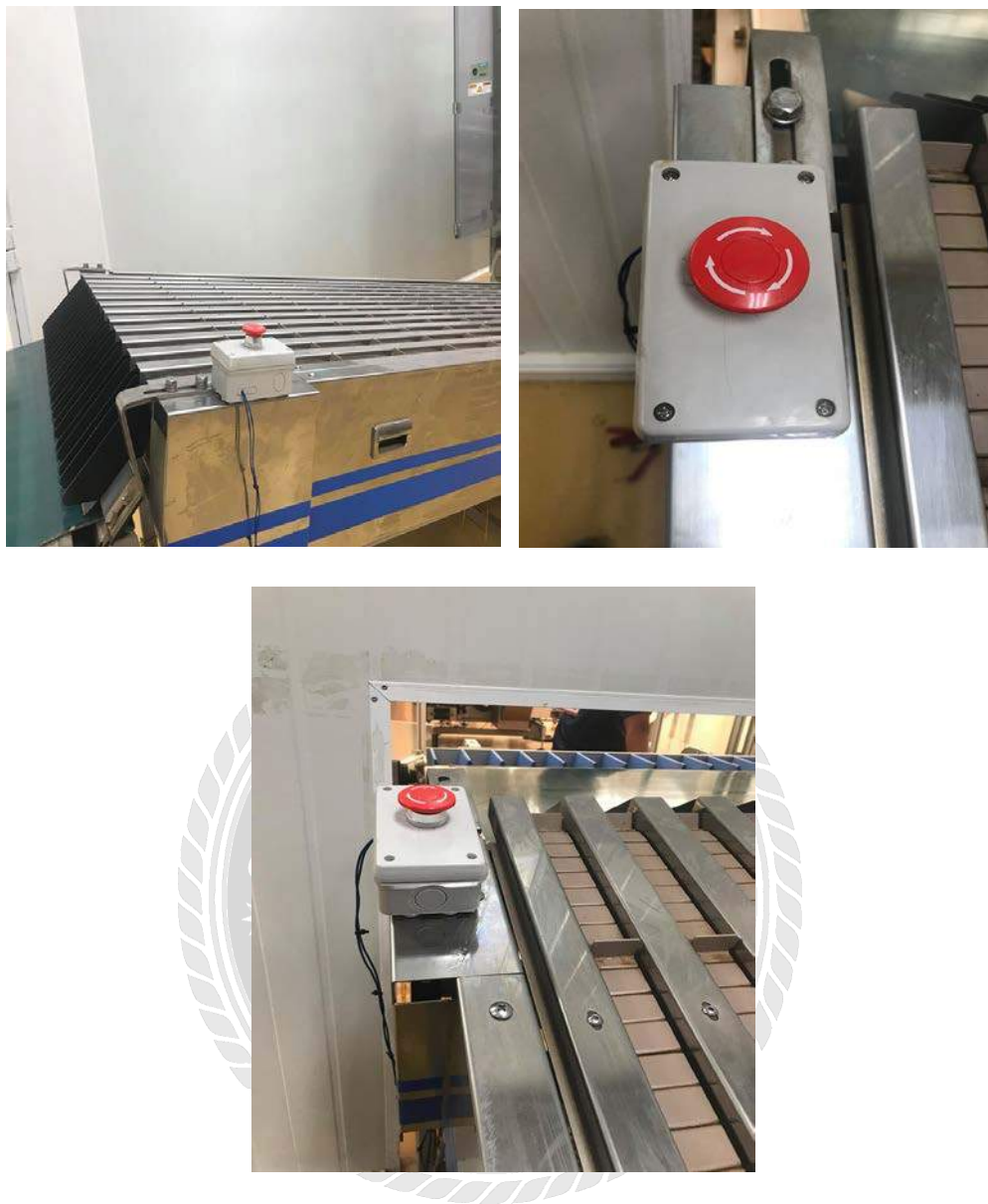
รูปที่ 3.22 ติดตั้ง Emergency Stop Push Buttons เรียบร้อย
