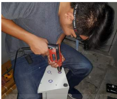
รูปที่ 3.13 เจาะตำแหน่งของอุปกรณ์และของเสา Smoke Detector
