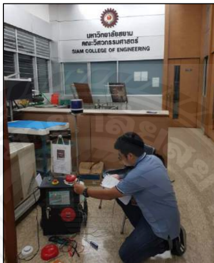
รูปภาพที่ 4.1 ทดสอบการตรวจจับความร้อน (Heat Detector) โดยใช้เครื่องมือวัดอุณหภูมิ
