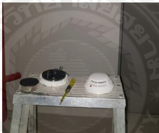
รูปที่ 3.7 การดำเนินการแก้ไข Smoke Detector ของพื้นที่ส่วนกลาง
