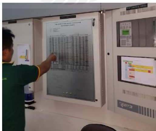
รูปที่ 3.8 การแก้ไขระบบตู้ควบคุมแจ้งเหตุเพลิงไหม้
