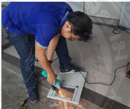
รูปที่ 3.14 จัดทำหน้าจอแสดงการทำงาน ของระบบ Fire Alarm
