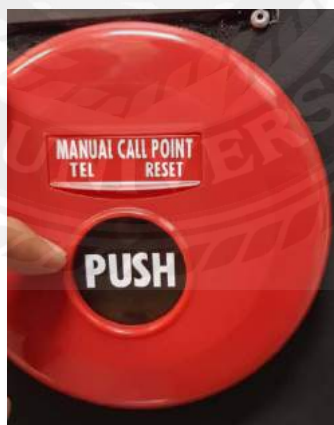
รูปภาพที่ 4.14 กดอุปกรณ์แจ้งเหตุด้วยมือผู้ใช้ (Manual Pull Station)
