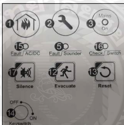
รูปภาพที่ 6.5 แสดงผลชุดควบคุมระบบแจ้งเตือนเหตุเพลิงไหม้ (Control Fire Alarm)
