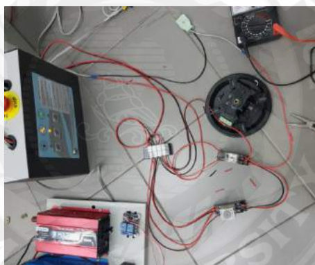
รูปที่ 3.20 ทดสอบการทำงานของระบบ Fire Alarm
