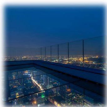
รูปที่ 4.13 พื้นที่กระจกลอยฟ้าที่ชั้น 78
