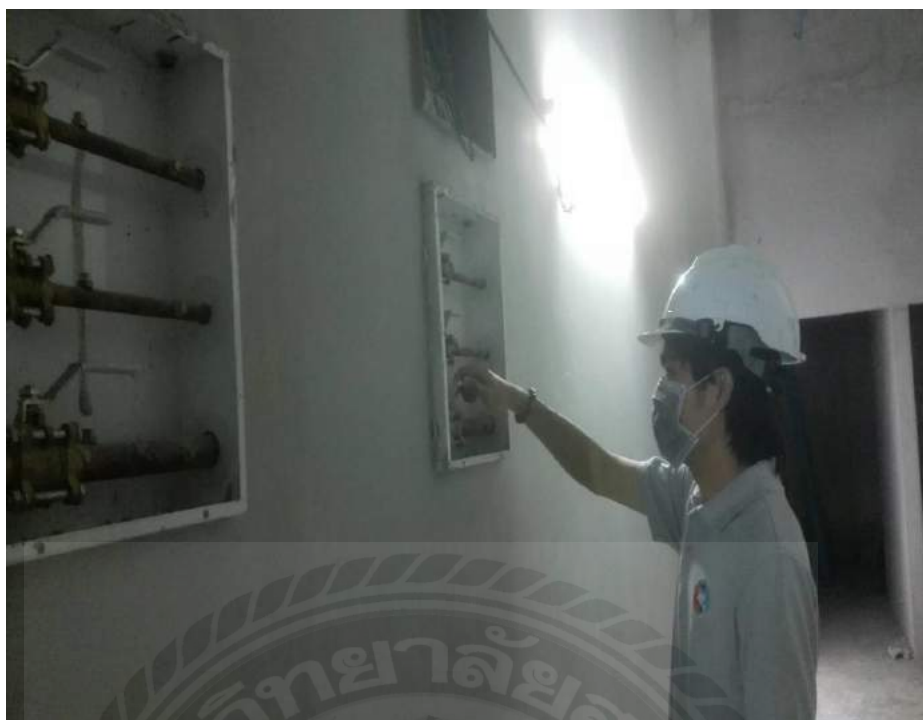
รูปที่ 6.1 ขณะทำการตรวจเช็คการรั่วของโซนวาล์วก๊าซทางการแพทย์
