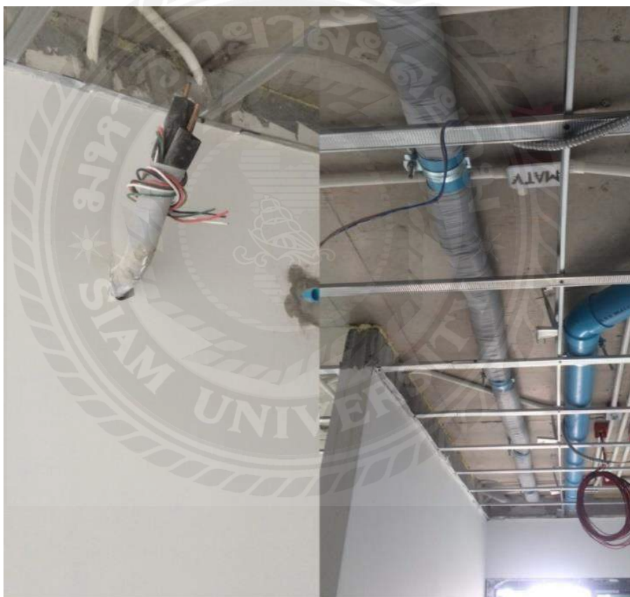
รูปที่ 3.7 การเดินท่อน้ำยาและสายไฟ
