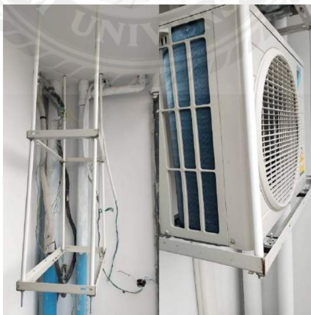
รูปที่ 3.7 การติดตั้งส่วนภายนอก
