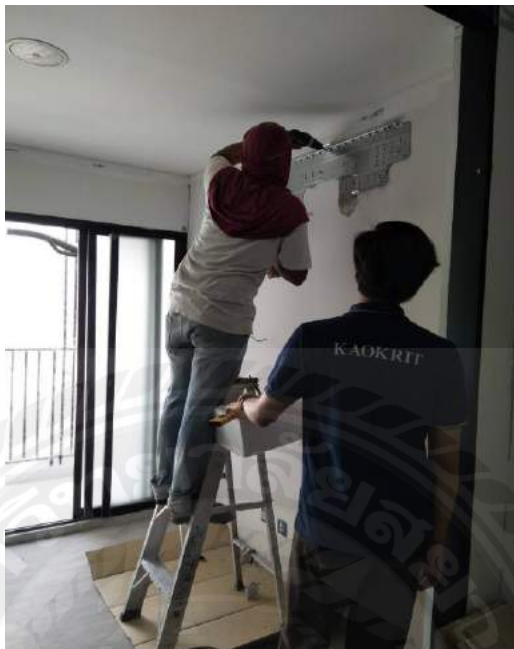
รูปที่ 3.7 การติดตั้งส่วนภายในห้อง
