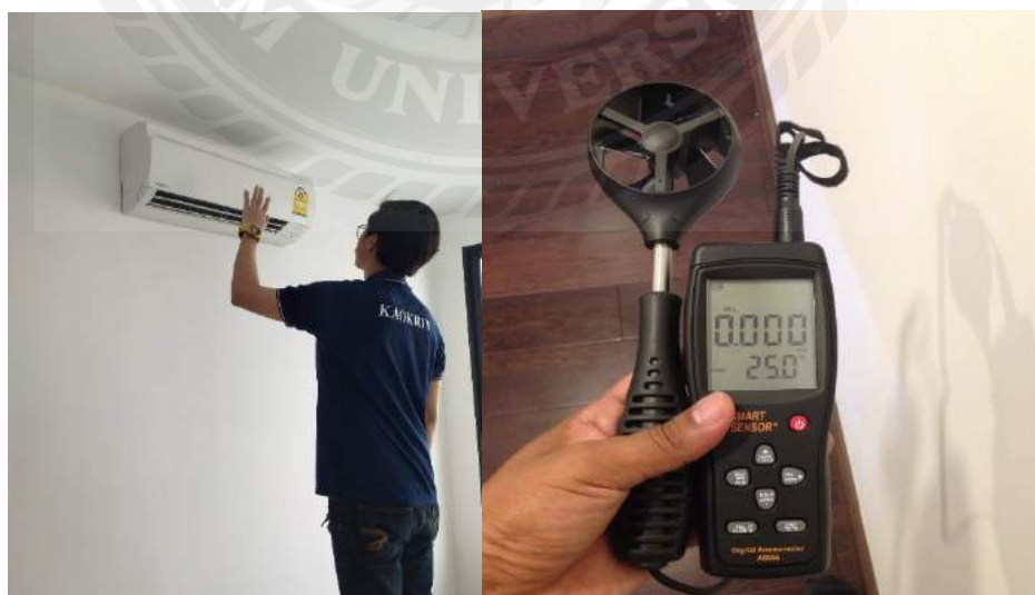
รูปที่ 3.7 ทดเครื่องปรับอากาศ
