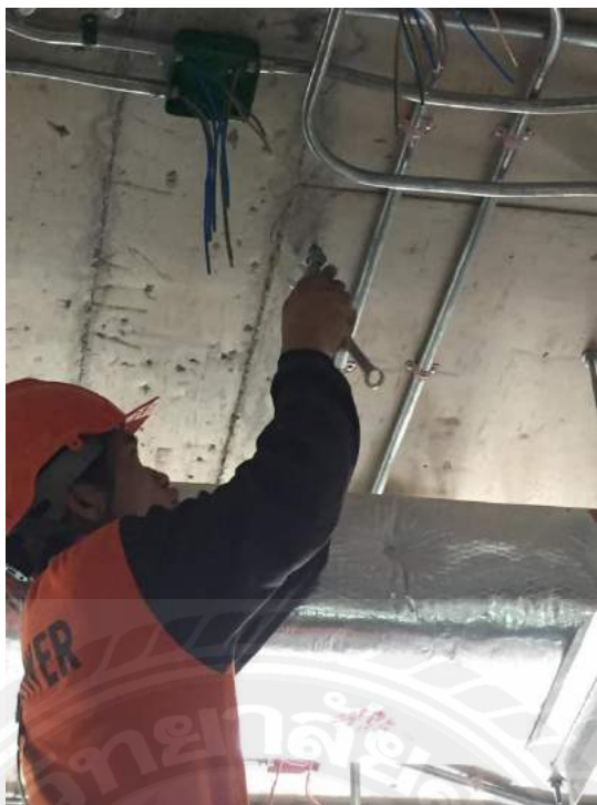
รูปที่ 3.11 ติดตั้ง อุปกรณ์รองรับท่อ ตามตำแหน่งในแบบ จากนั้นให้ติดตั้ง อุปกรณ์รองรับท่อ ตามระยะที่ถูกต้องตามแบบ ตรวจสอบเชิงการขันน็อต เกลียวยี่สิบของ อุปกรณ์รองรับท่อ ให้เรียบร้อย
