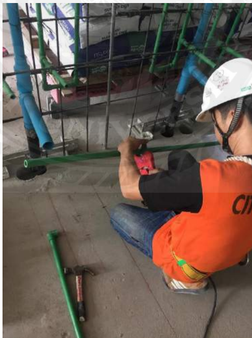
รูปที่ 3.11 ติดตั้ง อุปกรณ์รองรับท่อ ตามตำแหน่งในแบบ จากนั้นให้ติดตั้ง อุปกรณ์รองรับท่อ ตามระยะที่ถูกต้องตามแบบ ตรวจสอบเชิงการขันน็อต เกลียวยี่สิบของ อุปกรณ์รองรับท่อ ให้เรียบร้อย
