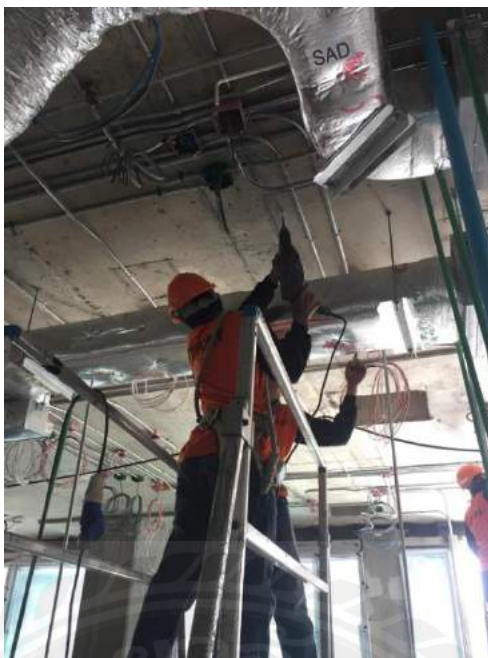
รูปที่ 3.9 เจาะพื้นเพดานด้วยสว่านเพื่อติดตั้งฟูกเหล็กยึด อุปกรณ์รองรับท่อ เมื่อมีเส้นฉนวนบนเพดาน ให้เราทำการเจาะเพดานตามระยะการติดตั้ง อุปกรณ์รองรับท่อ เพื่อติดตั้งฟูกเหล็กยึด อุปกรณ์รองรับท่อ กับ เพดาน
