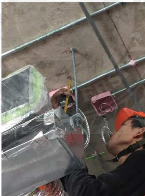
รูปที่ 3.9 เจาะพื้นเพดานด้วยสว่านเพื่อติดตั้งฟูกเหล็กยึด อุปกรณ์รองรับท่อ เมื่อมีเส้นฉนวนบนเพดาน ให้เราทำการเจาะเพดานตามระยะการติดตั้ง อุปกรณ์รองรับท่อ เพื่อติดตั้งฟูกเหล็กยึด อุปกรณ์รองรับท่อ กับ เพดาน
