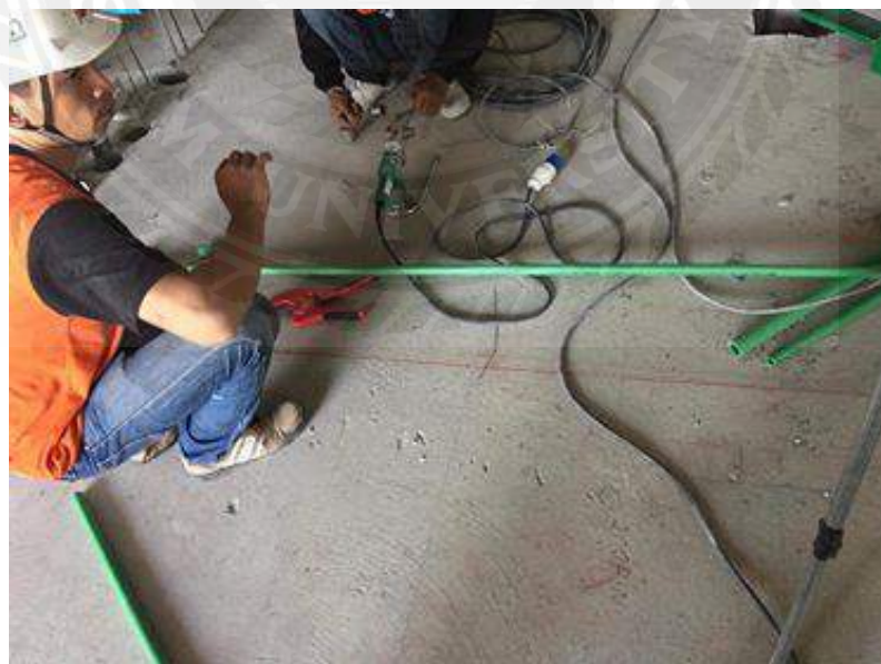
รูปที่ 3.14 นำมาประกอบท่อและข้อต่อเพื่อยกขึ้นไปติดตั้ง นำท่อที่เชื่อมเสร็จแล้วมาประกอบกัน หลังให้นำมาวางตามเส้นแนวท่อที่กำหนดไว้ และนำ ขึ้นไปติดตั้ง
