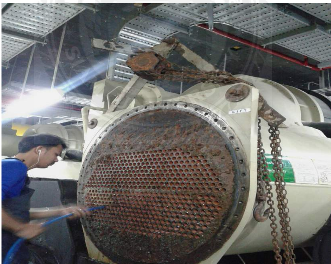
รูปที่ จ Team ช่าง ทำการล้างท่อที่เครื่อง Chiller
