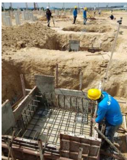
รูปที่ 4.32 ทีมสำรวจให้ระดับหลัง Footing
