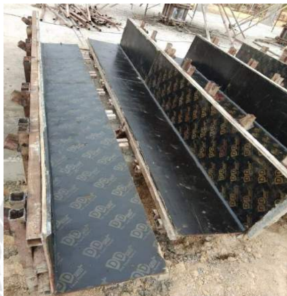
รูปที่ 4.64 ไม้แบบเสาที่พร้อมสวมเหล็กเสา
