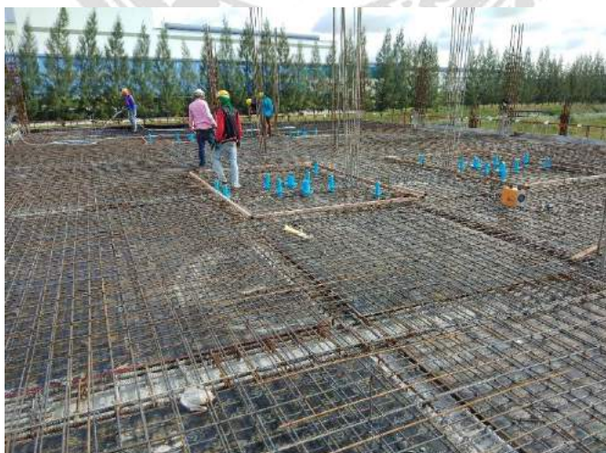
รูปที่ 4.58,4.59,4.60 หาดำแหน่งวางท่อ แล้วยึดเพื่อไม่ให้ตำแหน่งเคลื่อนในขณะเทคอนกรีต
