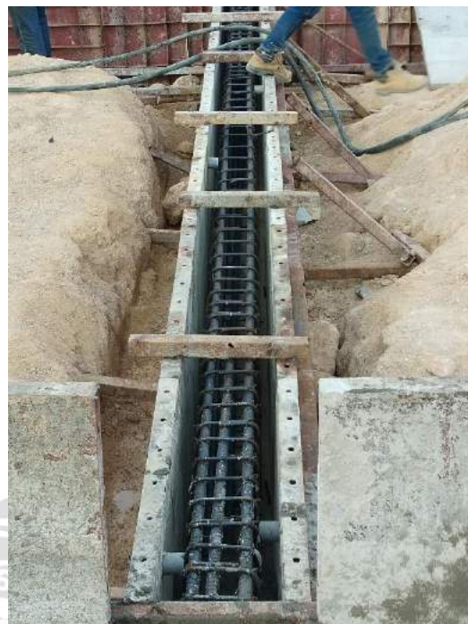
รูปที่ 4.47,4.48 ตัวอย่างคานที่พร้อมเทคอนกรีตแล้ว
