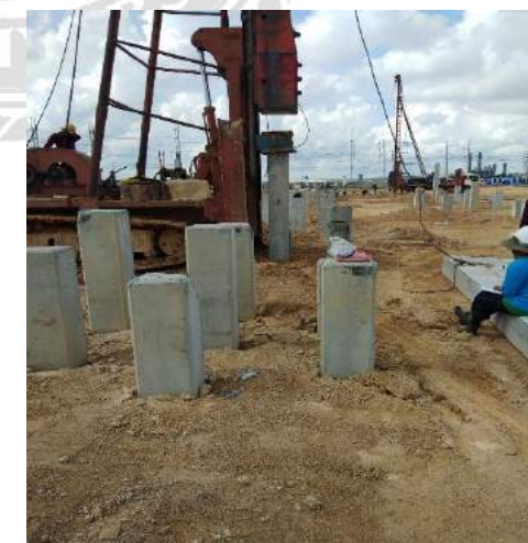
รูปที่ 4.12 นับ Blows Count , Last Ten Blows
