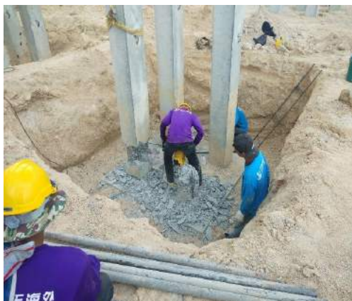
รูปที่ 4.22 ตัดเสาเข็มส่วนเกินออก
