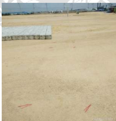
รูปที่ 4.5 ผังหมุดตำแหน่งไลน์เสาเข็มที่วางเสร็จแล้ว
