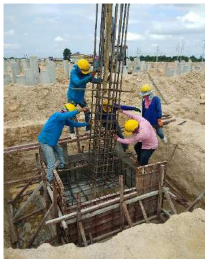
รูปที่ 4.33 ฐาน F4 ขณะกำลังลงเหล็กเสาะ
