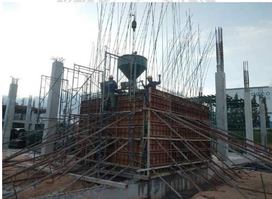
รูปที่ 5.5 ติดตั้งค้ำยันผนังลิฟท์
