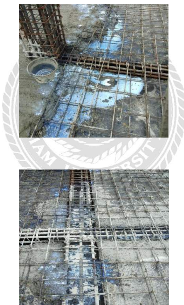
4.63 ใช้น้ำยาประสานในกรณีที่เทคอนกรีตไม่ต่อเนื่อง
