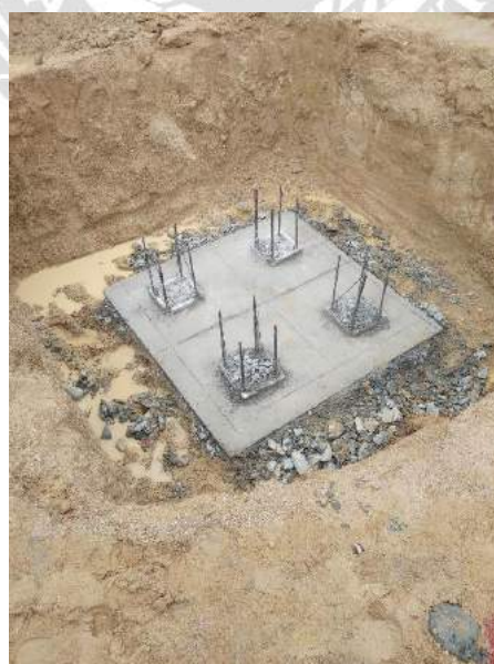
รูปที่ 4.28 เมื่อได้ตำแหน่งที่แน่นอนแล้วตีไลน์กรอบ Footing
