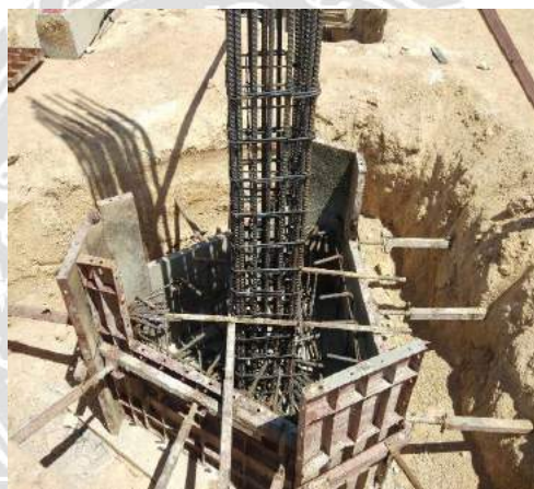
รูปที่ 4.34 ตัวอย่างฐาน F3 ที่พร้อมเทคอนกรีตแล้ว
