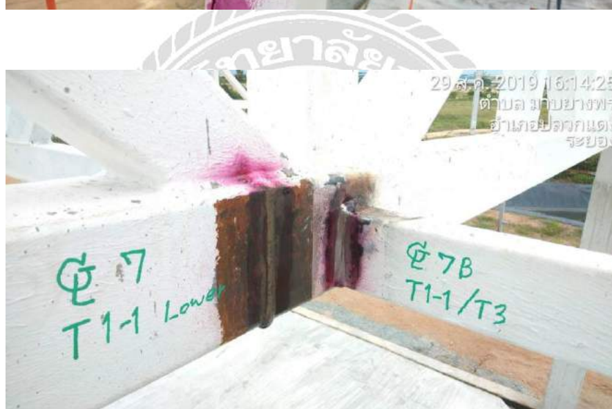
รูปที่ 5.2 ตรวจสอบรอยเชื่อม โดยใช้สีน้ำยา
