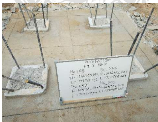
รูปที่ 4.30 ตัวอย่างแสดงการเปรียบเทียบพิกัดจริง กับ พิกัดใหม่ที่เข็มหินศูนย์
