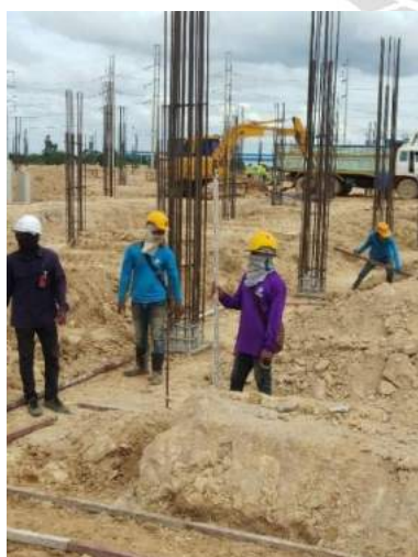
รูปที่ 4.42,4.43,4.44 เชีกระดับไม้แบบ , เชีกระดับน้ำไม้แบบ , บริเวณที่เข้าแบบเรียบร้อยแล้ว
