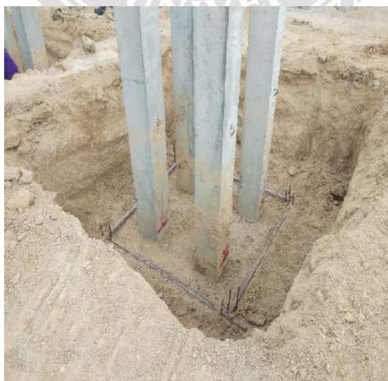
รูปที่ 4.19 ระดับดินที่ปรับแล้ว พร้อมเข้าแบบเทดิน
