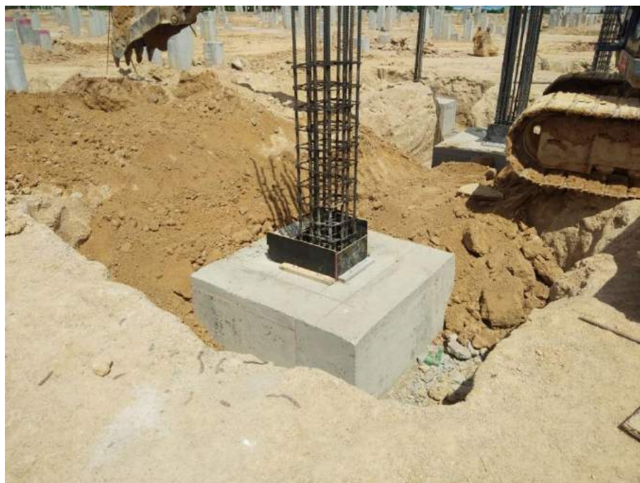
รูปที่ 4.40 เข้าแบบเทคอนกรีตเพื่อหล่อตอม่อให้เชื่อมต่อกับฐานราก
