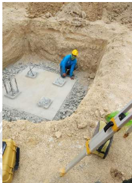
รูปที่ 4.27 การหาตำแหน่งกรอบของ Footing
