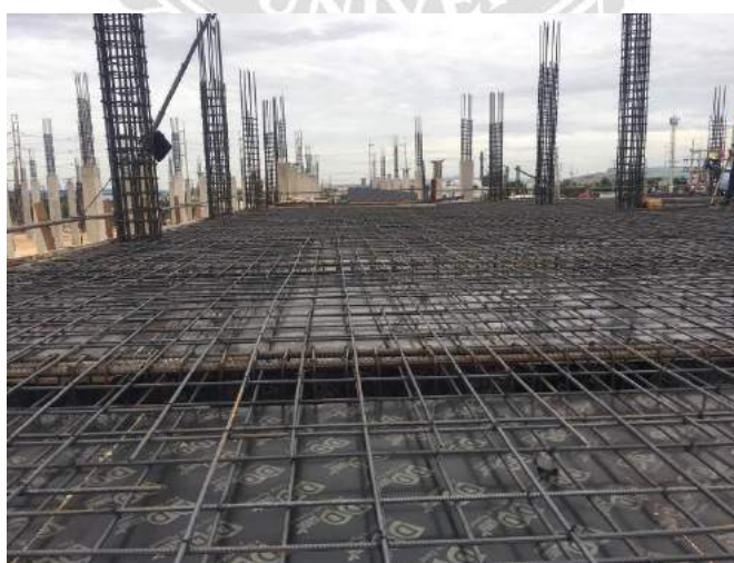
รูปที่ 4.55,4.56,4.57 เข้าไม้แบบรับท้องพื้นชั้น2 , พื้นต่างระดับ , ทำความสะอาดแบบพร้อมเทคอนกรีต
