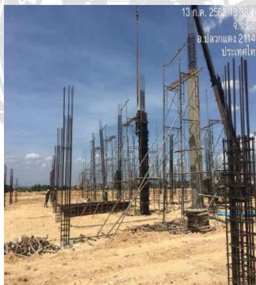
รูปที่ 4.67 ตัวอย่างเสาที่แกะไม้แบบแล้ว
