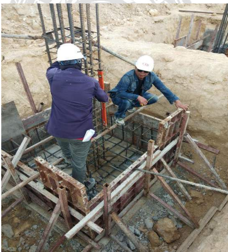
รูปที่ 4.36, 4.37 ก่อนเทคอนกรีตให้ที่ปรึกษา ตรวจสอบความถูกต้อง
