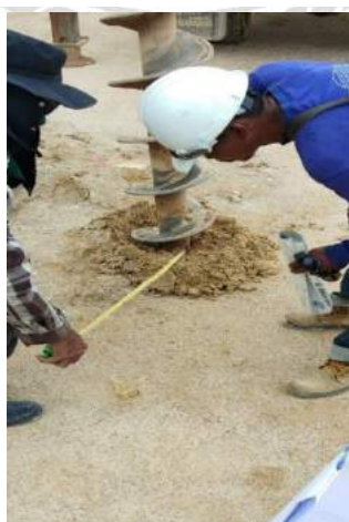
รูปที่ 4.8 Off set ตำแหน่งเข็มเจาะ
