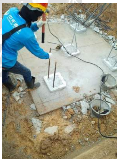
รูปที่ 4.25 เสียบเหล็กในตำแหน่งที่เหล็ก
