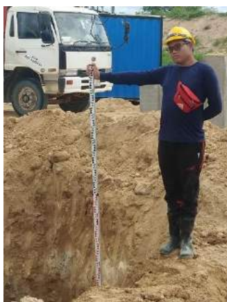
รูปที่ 4.15 เช็คระดับความลึกของดิน
