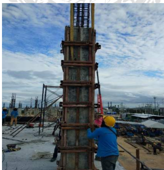
รูปที่ 4.65 สวมไม้แบบ
