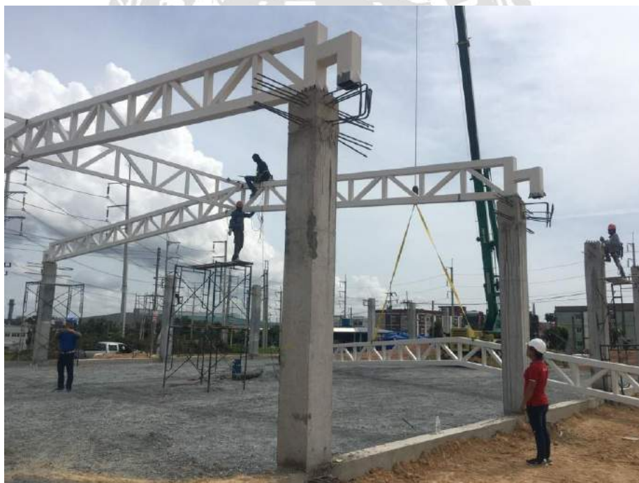
รูปที่ 5.3 ติดตั้งชิ้นส่วนโครงสร้างเหล็ก
