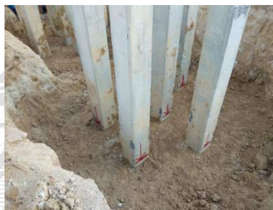
รูปที่ 4.16 ดินที่ปรับระดับ และ ให้ระดับเทลิ้น
