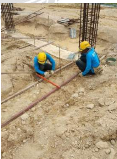
รูปที่ 4.42,4.43,4.44 เชีกระดับไม้แบบ , เชีกระดับน้ำไม้แบบ , บริเวณที่เข้าแบบเรียบร้อยแล้ว
