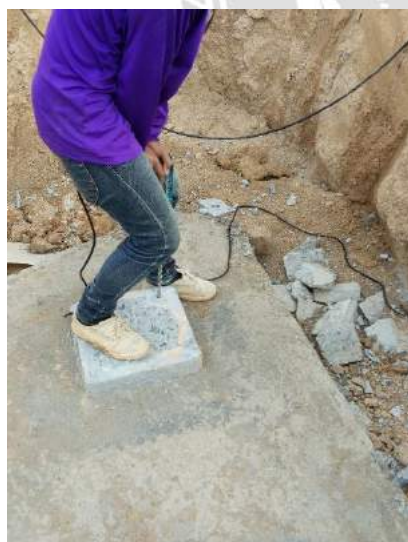
รูปที่ 4.24 ใช้สว่านเจาะรู โดยมีความลึก 20 cm.
