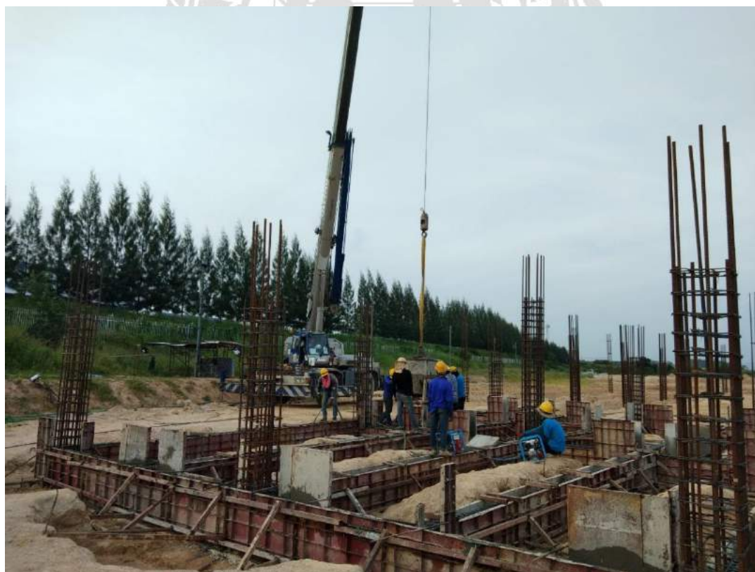
รูปที่ 4.49 กรณีพื้นที่เทคอนกรีตมีจำกัด จึงใช้เครนช่วยลำเลียงคอนกรีต
