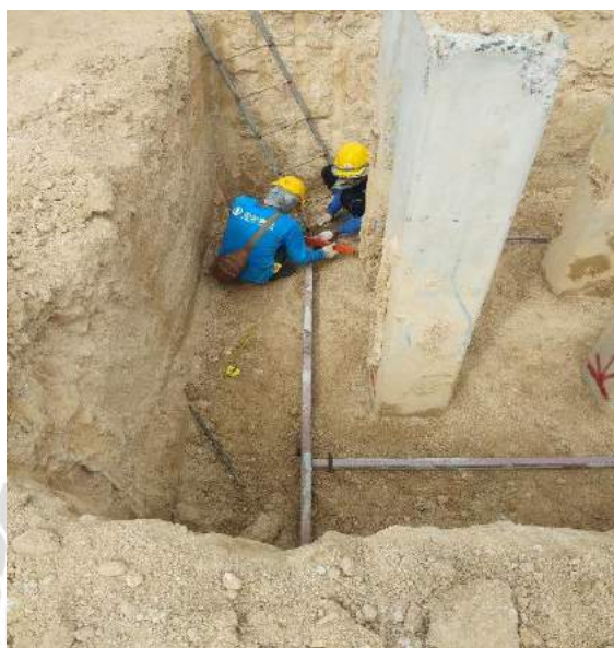
รูปที่ 4.18 เข้าแบบเทดิน เผื่อระยะ Off set เพื่อสำหรับใช้วางไม้แบบของ Footing
