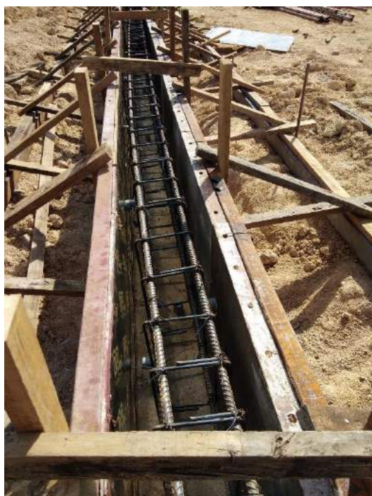
รูปที่ 4.47,4.48 ตัวอย่างคานที่พร้อมเทคอนกรีตแล้ว
