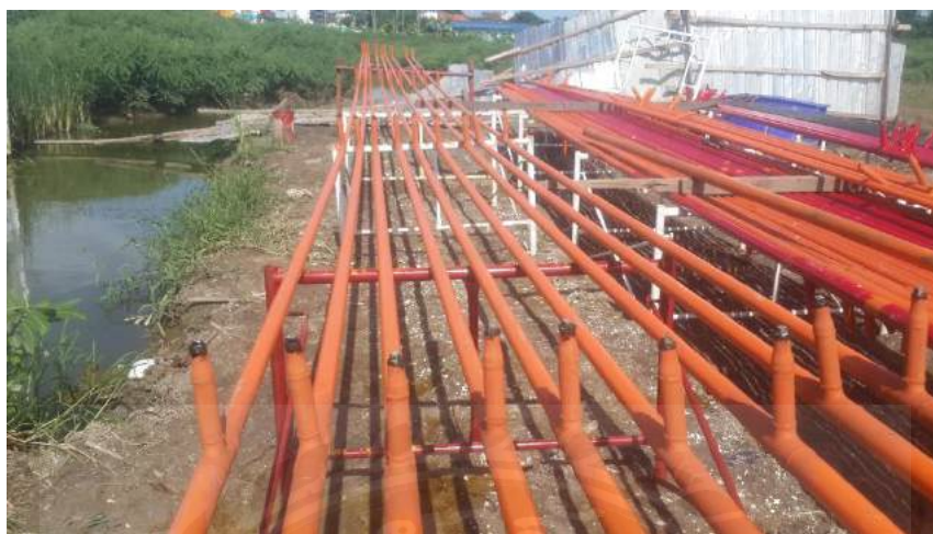
รูปที่ 3.16 ภาพท่ที่ทำการเชื่อมเสร็จเรียบร้อยแล้วและลงสีกันสนิมในชั้นที่ 2
