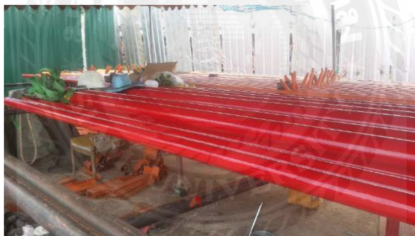
รูปที่ 3.17 ภาพท่ที่ทำการทาสีแดงทั้ง 2 ชั้น
