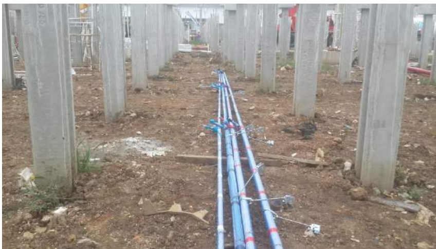
รูปที่ 3.18 ภาพท่อที่ทำพันผ้าก่อนทำการติดตั้งเพื่อป้องกัน โฟมพียู
