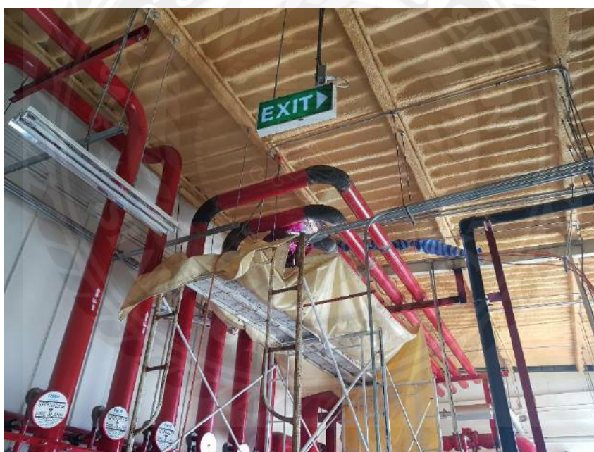
รูปที่ 3.21 ภาพการเชื่อมประกอบท่อดับเพลิงภายในห้องปั๊ม
