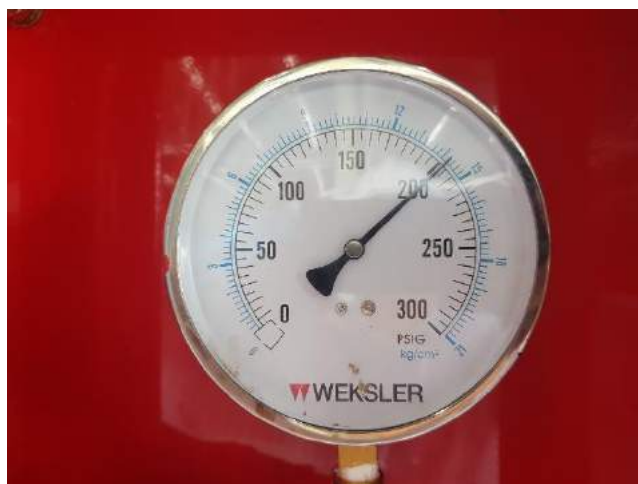
รูปที่ 3.22 ภาพการทดสอบระบบป้องกันอัคคีภัย
