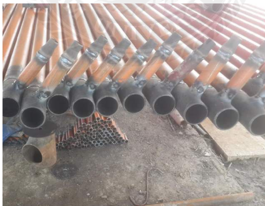
รูปที่ 3.15 ภาพท่อที่ทำการเชื่อมเสร็จเรียบร้อยแล้ว
