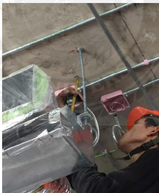
รูปที่ 3.9 เจาะพื้นเพดานด้วยสว่านเพื่อติดตั้งสลักเกลียวขยายตัวเหล็กยึด อุปกรณ์รองรับท่อ เมื่อมีเส้นทาบบนเพดาน ให้เราทำการเจาะเพดานตามระยะการติดตั้ง อุปกรณ์รองรับท่อ เพื่อติดตั้งฟูกเหล็กยึด อุปกรณ์รองรับท่อ กับ เพดาน
