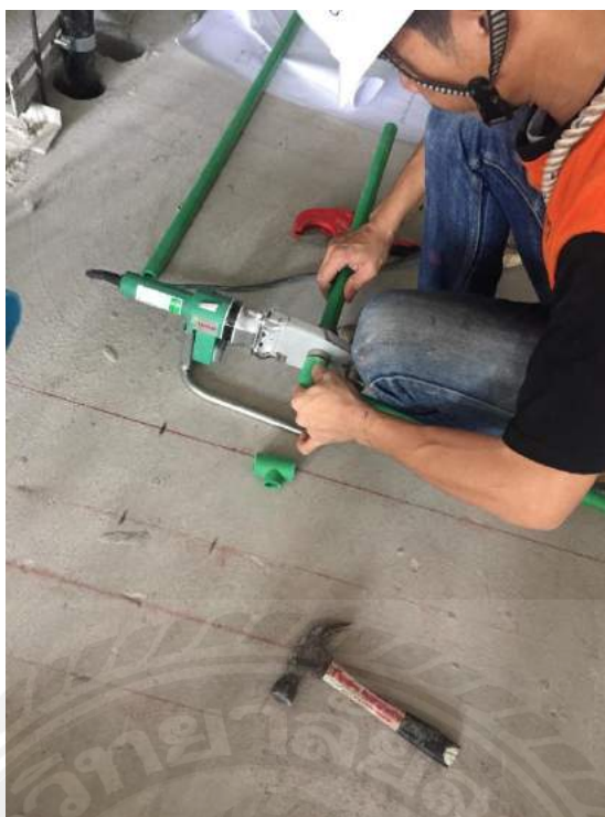
รูปที่ 3.13 เชื่อมท่อ พีพีอาร์ ด้วยเครื่องเชื่อม นำท่อที่ตัดได้มาตามขนาดที่กำหนด มาเชื่อมต่อกับข้อต่อต่างๆด้วยเครื่องเชื่อมร้อน ทั้งไว้ ประมาณ 3-4 วินาที หรืออาจนานกว่า ตามแต่ละขนาดของท่อ
