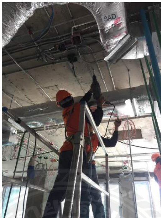
รูปที่ 3.9 เจาะพื้นเพดานด้วยสว่านเพื่อติดตั้งสลักเกลียวขยายตัวเหล็กยึด อุปกรณ์รองรับท่อ เมื่อมีเส้นทาบบนเพดาน ให้เราทำการเจาะเพดานตามระยะการติดตั้ง อุปกรณ์รองรับท่อ เพื่อติดตั้งฟูกเหล็กยึด อุปกรณ์รองรับท่อ กับ เพดาน
