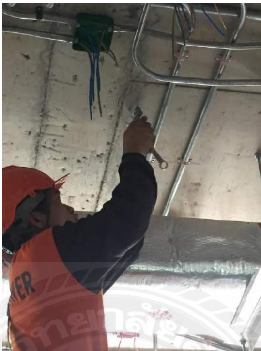
รูปที่ 3.11 ติดตั้ง อุปกรณ์รองรับท่อ ตามตำแหน่งในแบบ จากนั้นให้ติดตั้ง อุปกรณ์รองรับท่อ ตามระยะที่ถูกต้องตามแบบ ตรวจสอบความเรียบร้อย ของเนื้อซีเมนต์เกลียวของ อุปกรณ์รองรับท่อ ให้เรียบร้อย
