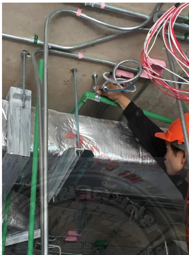
รูปที่ 3.15 นำท่อที่ประกอบสำเร็จแล้วนำขึ้นมาติดตั้งกับ อุปกรณ์รองรับท่อ ที่ติดตั้งไว้ก่อนแล้ว นำท่อที่ประกอบเสร็จเรียบร้อยแล้ว ขึ้นมาติดตั้งกับ อุปกรณ์รองรับท่อ ที่ติดตั้งไว้ก่อนแล้ว ตรวจสอบการติดตั้ง โดยการขันน็อตยึดทุกตัวให้เรียบร้อยและตรวจสอบอีกครั้ง เป็นอันเสร็จสิ้นการ ติดตั้ง
