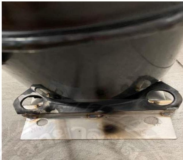
รูปที่ 3.8.1.9 เชื่อมฐานคอมเพรสเซอร์
