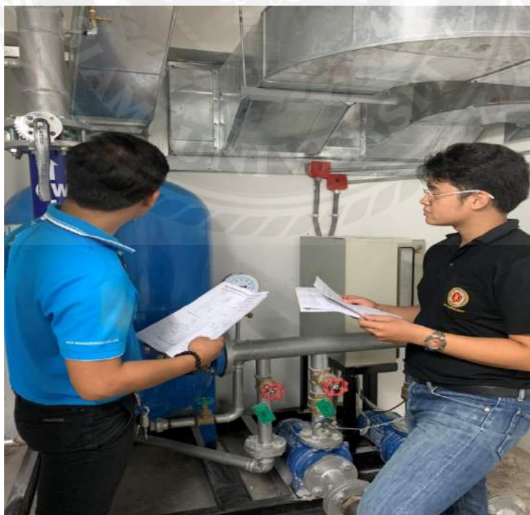
รูปที่ 3.7.3 พนักงานที่ปรึกษาอธิบายความสำคัญของระบบปั๊มเพิ่มแรงดัน
