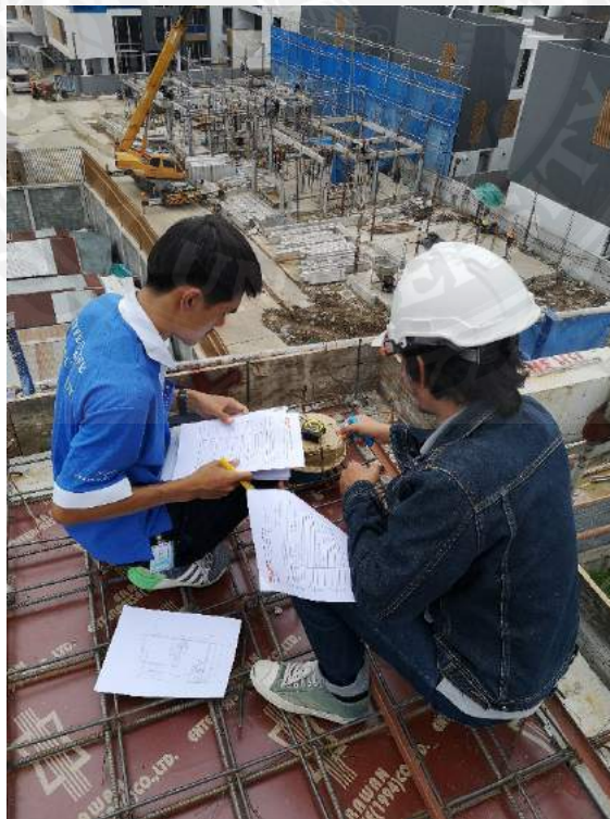
รูปที่ 4 ส่งงานการติดตั้งท่อระบายน้ำบนอาคาร 30
