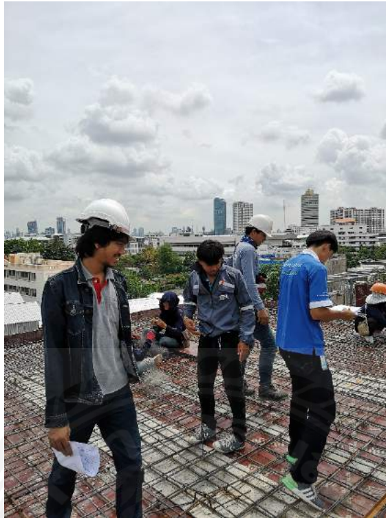
รูปที่ 3 ส่งงานการติดตั้งท่อระบายน้ำบนอาคาร 33
