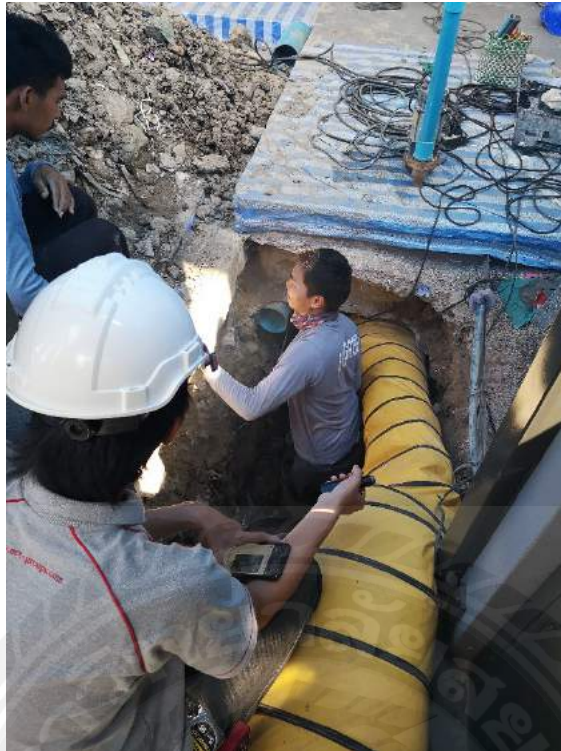
รูปที่ 1 งานขุดพื้นใต้บ้านเพื่อแก้ไขท่อไม่ลาดเอียง
