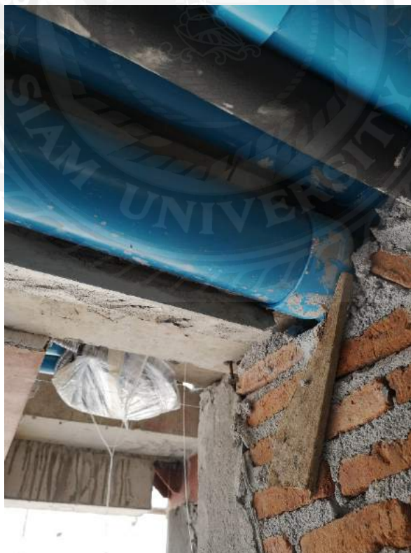
รูปที่ 8 การแก้ไขท่อไม่พันผ้า
