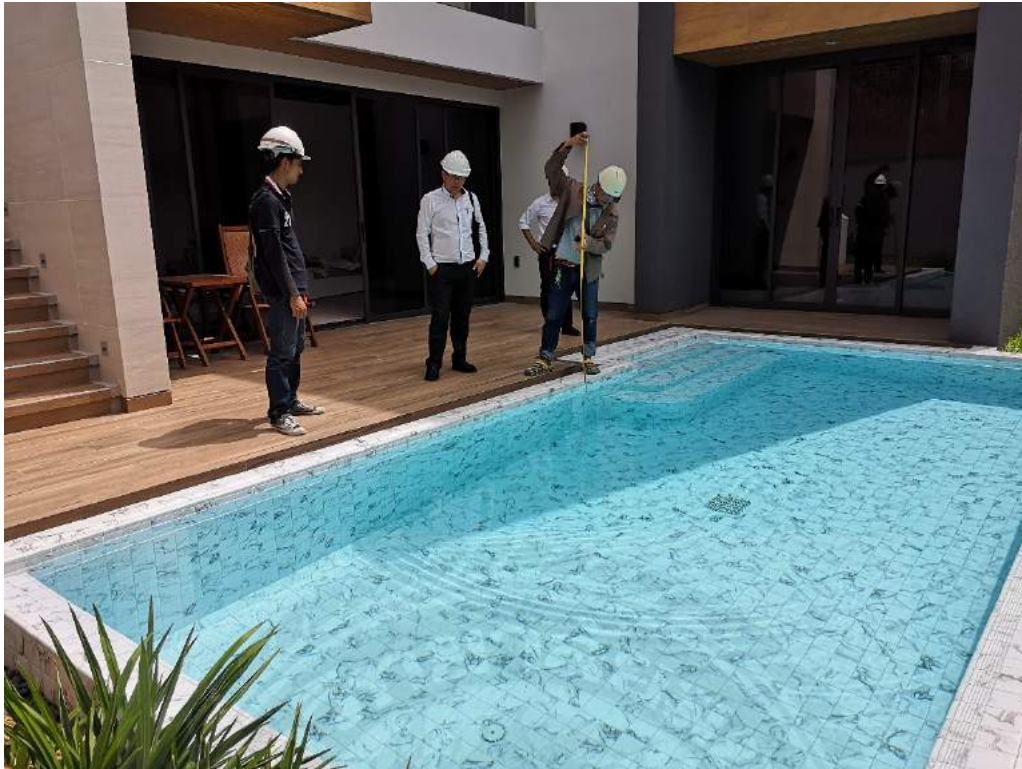
รูปที่ 15 วิศวกรงานระบบพาณิชยกรรมอาจารย์เดินตรวจบ้านตัวอย่าง
