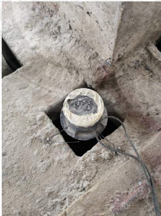
รูปที่ 2 ตรวจสอบงานวางช่องระบายน้ำที่พื้น
