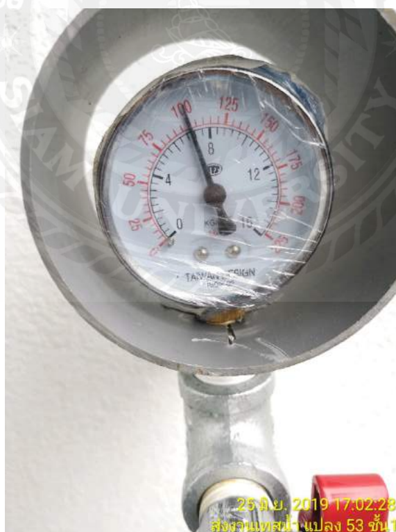
รูปที่ 6 ตรวจเช็คแรงดันในท่อน้ำดี
