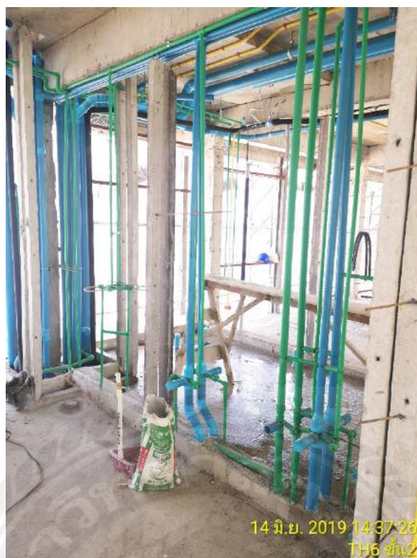
รูปที่ 5 ส่งงานการติดตั้งท่อ S,V,W,CW ในอาคาร
