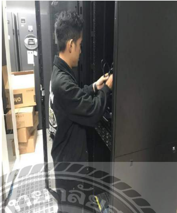
รูปที่ ก.5 ติดตั้งระบบและนำปัญหามาปรับปรุงแก้ไข
