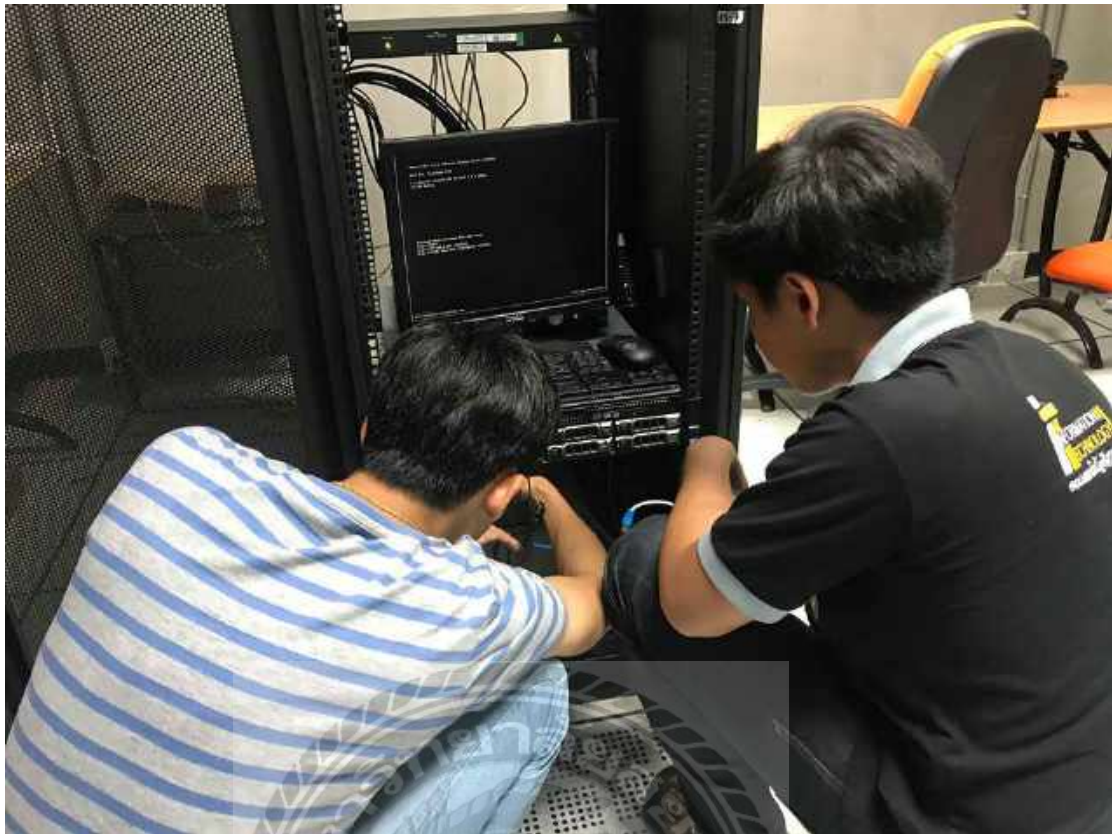
รูปที่ ข.3 ขณะทำการติดตั้งระบบปฏิบัติการ Windows Server 2016 R2
