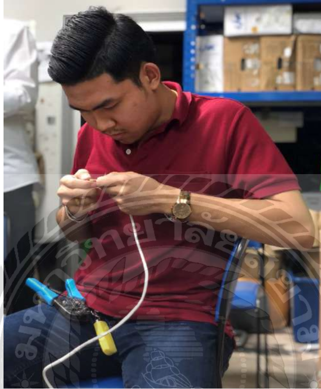
รูปที่ ข.1 การเข้าหัวสายแลนเพื่อเตรียมการเปิดสาขาใหม่
