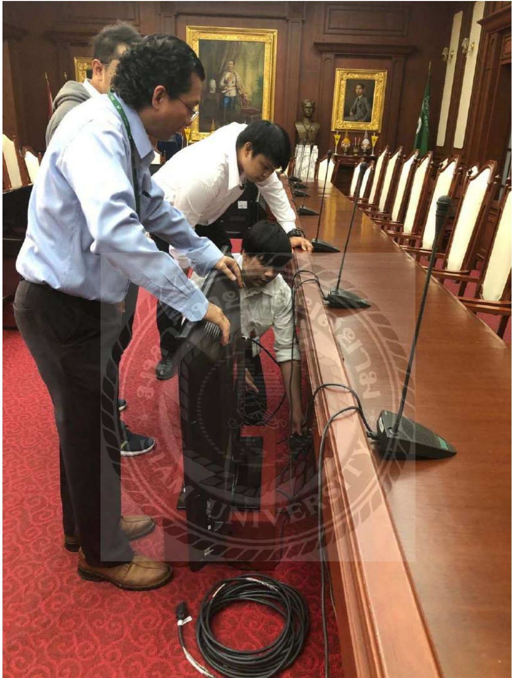
ภาพที่ ก. 3 ติดตั้งอุปกรณ์ประเภทฮาร์ดแวร์ในการทำ Video Conference และตรวจสอบการตั้งค่า IP Address ของอุปกรณ์
