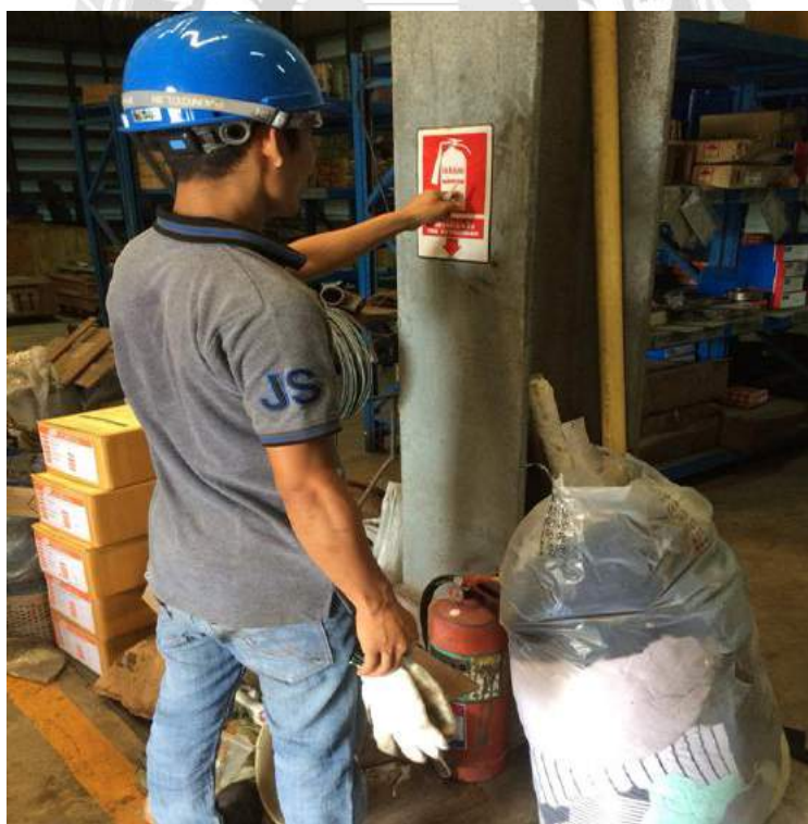
รูปที่ 4.3 วัดระดับการติดตั้งถังดับเพลิง
