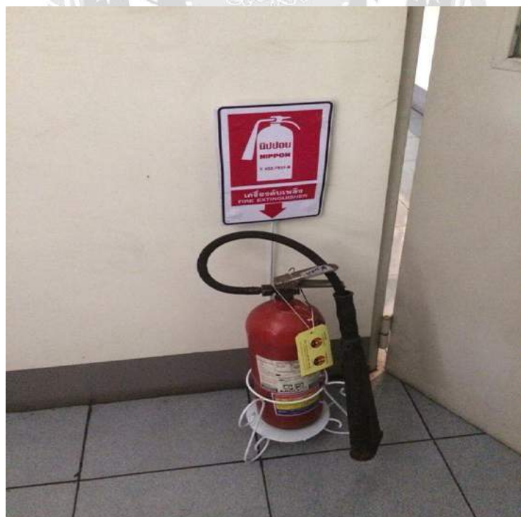
รูปที่ 4.11 ติดตั้งบริเวณหัวครัว
