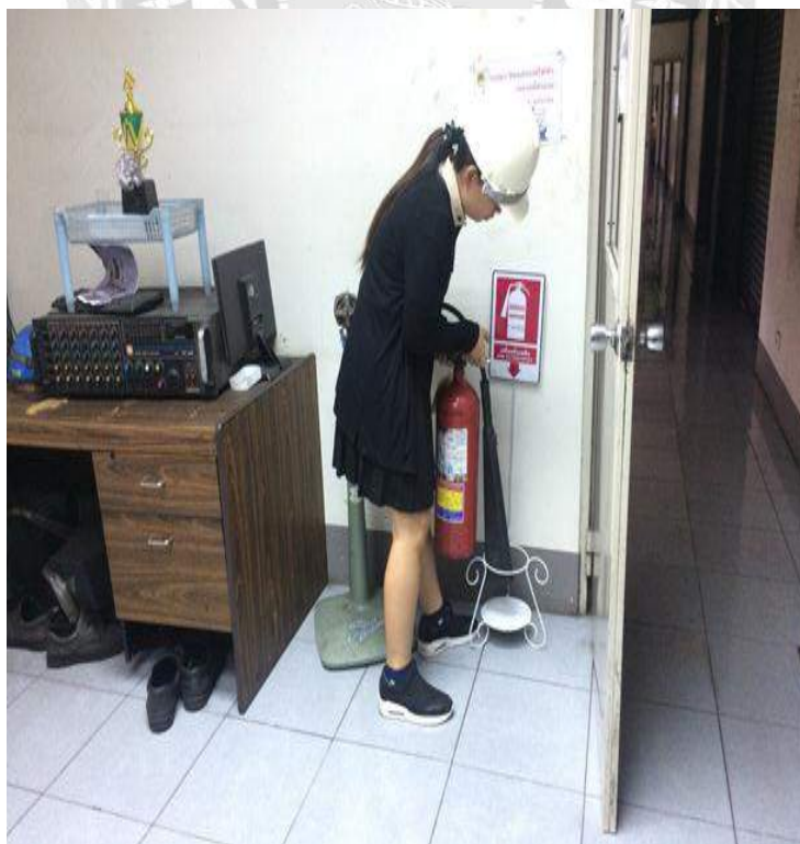
รูปที่ 4.9 ภายหลังติดตั้งฐานถังดับเพลิงบริเวณหน้าห้องควบคุม
