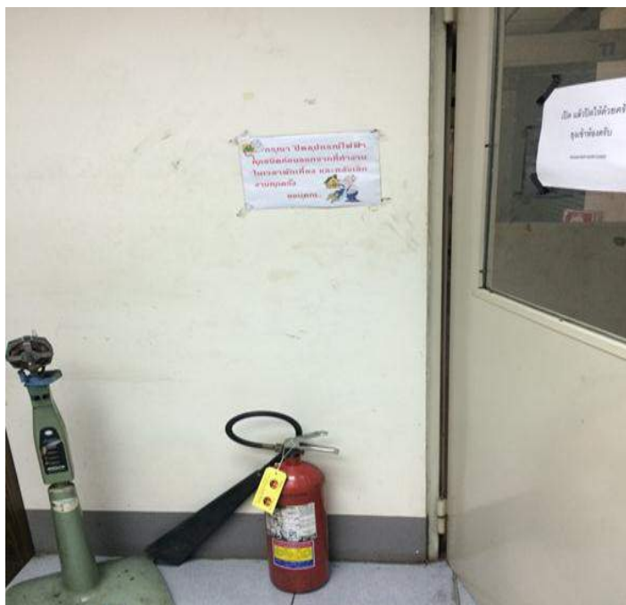
รูปที่ 4.8 พื้นที่จัดตั้งถังดับเพลิงเดิมซึ่งไม่มีฐานอาจทำให้เกิดอุบัติเหตุ
