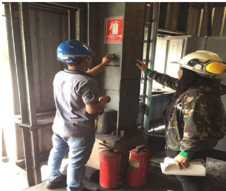
รูปที่ 4.2 ทำมาร์คตำแหน่งในการติดตั้งถังดับเพลิง
