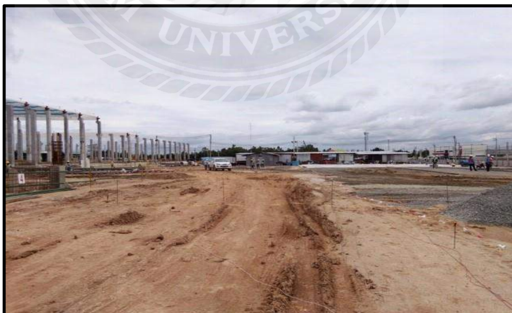
รูปที่ 3.6 รูปแบบลักษณะการติดตั้งเพื่อหาค่าความต้านทานที่หน้างานจริง
