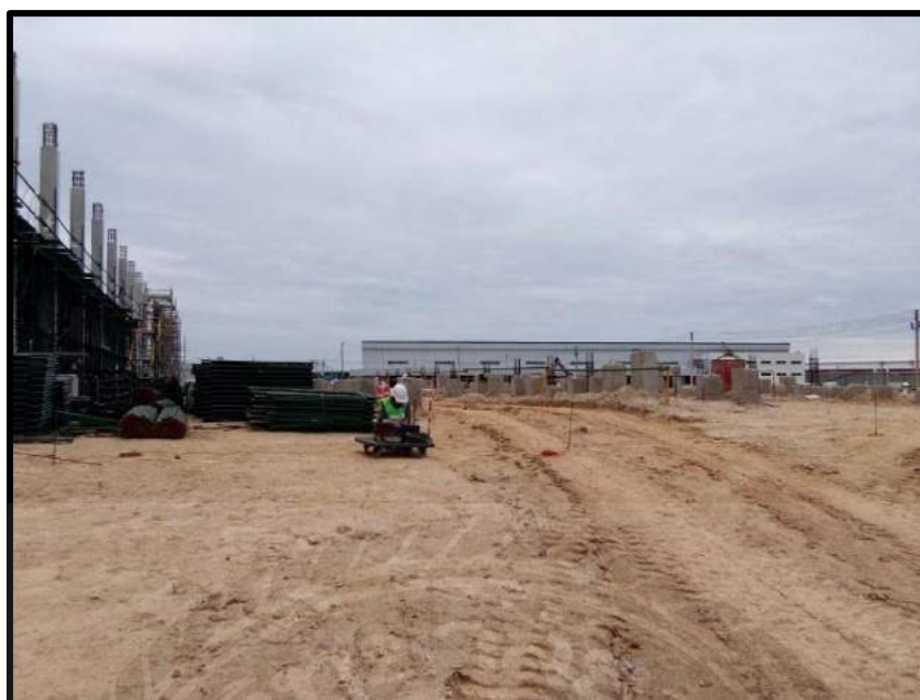
รูปที่ 3.8 รูปแบบลักษณะการติดตั้งเพื่อหาค่าความต้านทานของสายแต่ละขนาดที่หน้างานจริง
