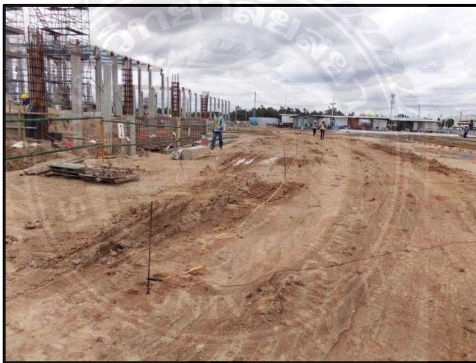
รูปที่ 3.7 รูปแบบลักษณะการติดตั้งเพื่อหาค่าความต้านทานของสายแต่ละขนาดที่หน้างานจริง
