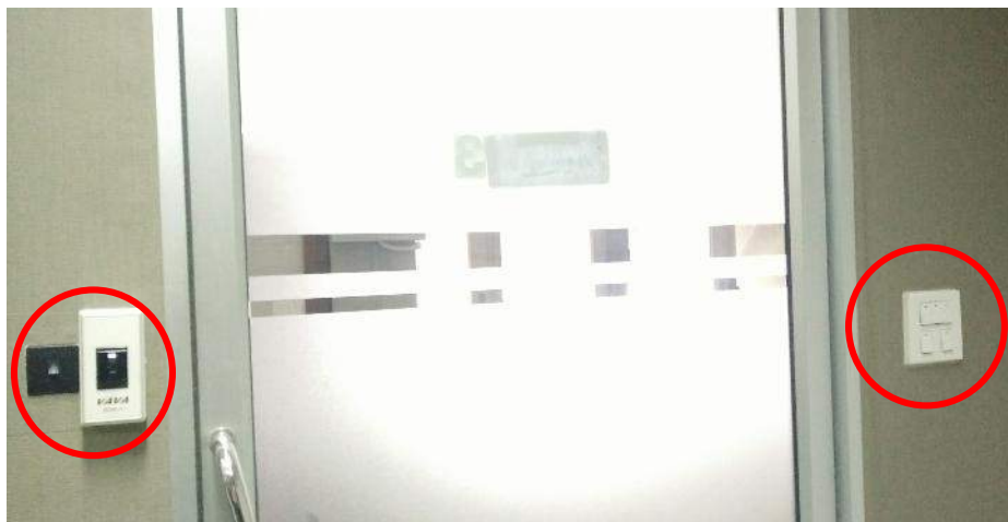
รูปที่ 4.6 ไม่มีการชี้แจงรายละเอียดการใช้งานว่า สวิตช์ไฟแต่ละปุ่มเป็นของไฟดวงใด
