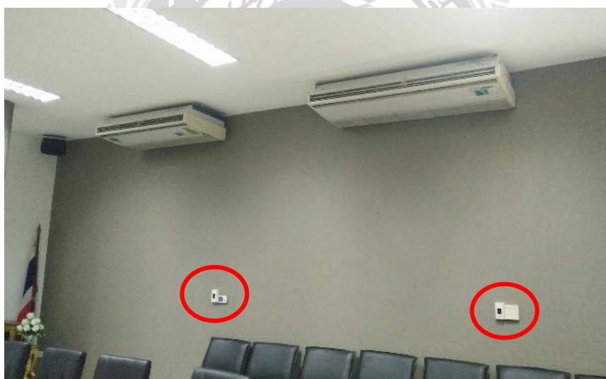
รูปที่ 4.7 ไม่มีการชี้แจงรายละเอียดการใช้งานว่า สวิตช์เป็นของเครื่องปรับอากาศเครื่องใด
