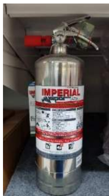
รูปภาพที่ 2.4 ถังดับเพลิงชนิดน้ำยาโฟม
