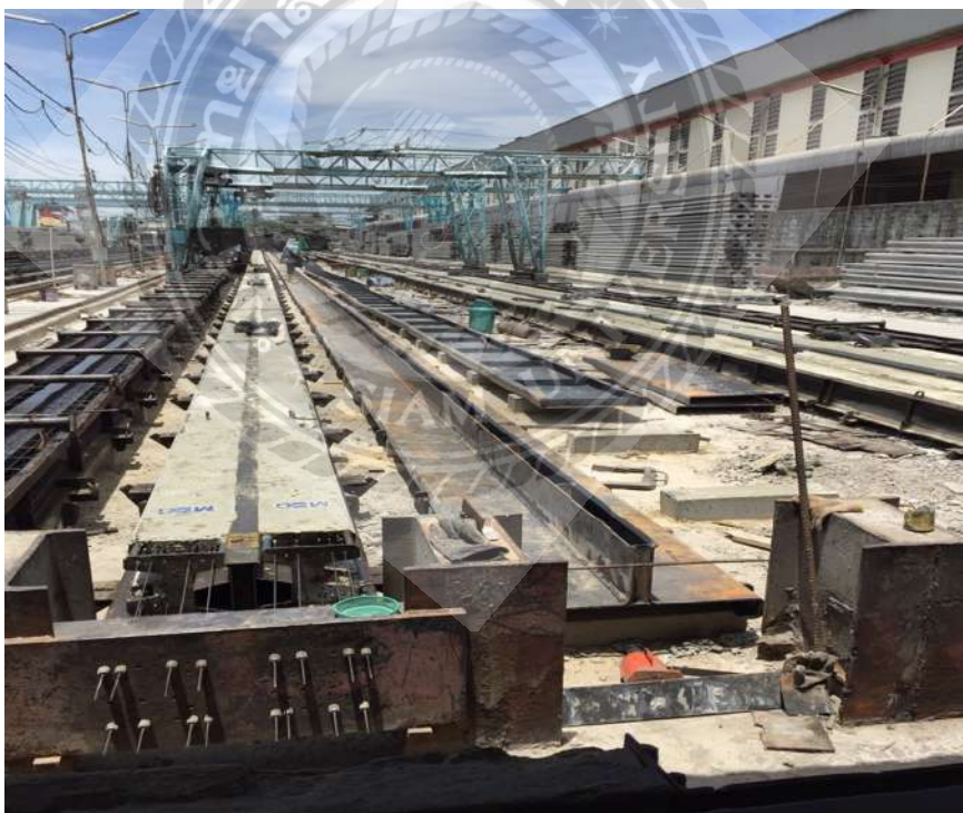
รูปที่ 4.1 สถานที่ทำการผลิตเสาเข็ม
