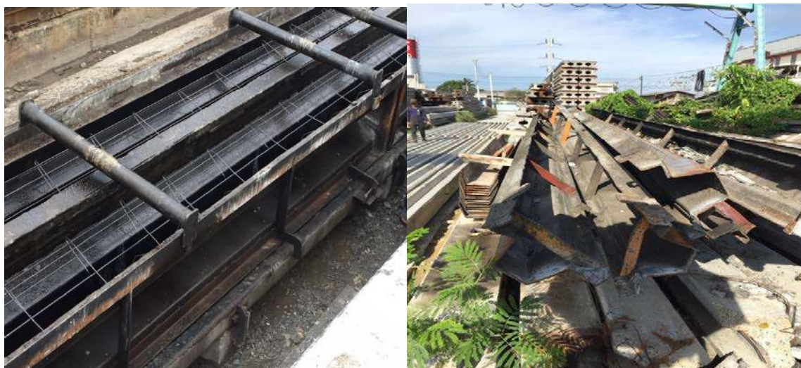
รูปที่ 4.2 ขั้นตอนการเตรียมงานก่อนเทปูนเพื่อทำเสาเข็มคอนกรีต
