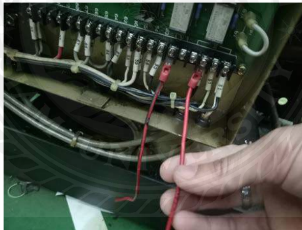
ภาพที่ 3-4 ต่อสายไฟเข้ากล่องไฟ
