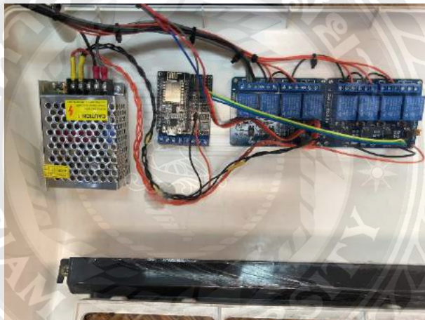
รูปที่ ก.4 การติดตั้งชุดสายไฟ
