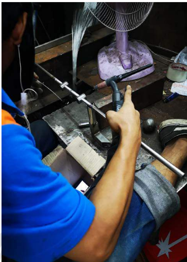
รูปที่ 3.36 เชื่อมเหล็กแกนกลางเข้ากับเหล็กเกรียว
