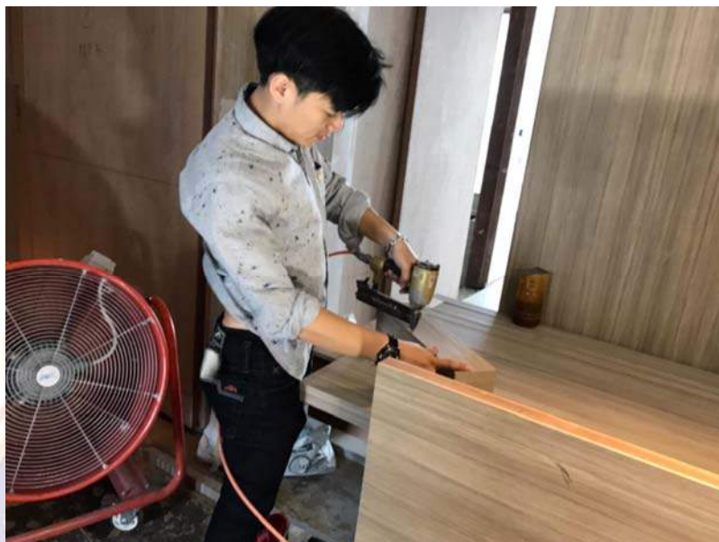
รูปที่ 3.12 การยึดแผ่นงานด้วยปืนลมเพื่อความแน่นหนา
