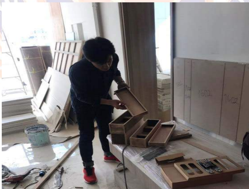
รูปที่ 3.13 การบังใบเพื่อการทำฝากล่อง
