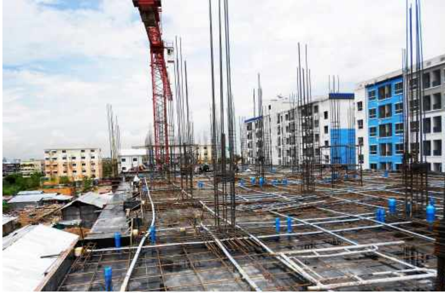
รูปที่ 2.5 การวางลวดอัดแรงและเหล็กเสริมคอนกรีตในระบบ Post Tension
