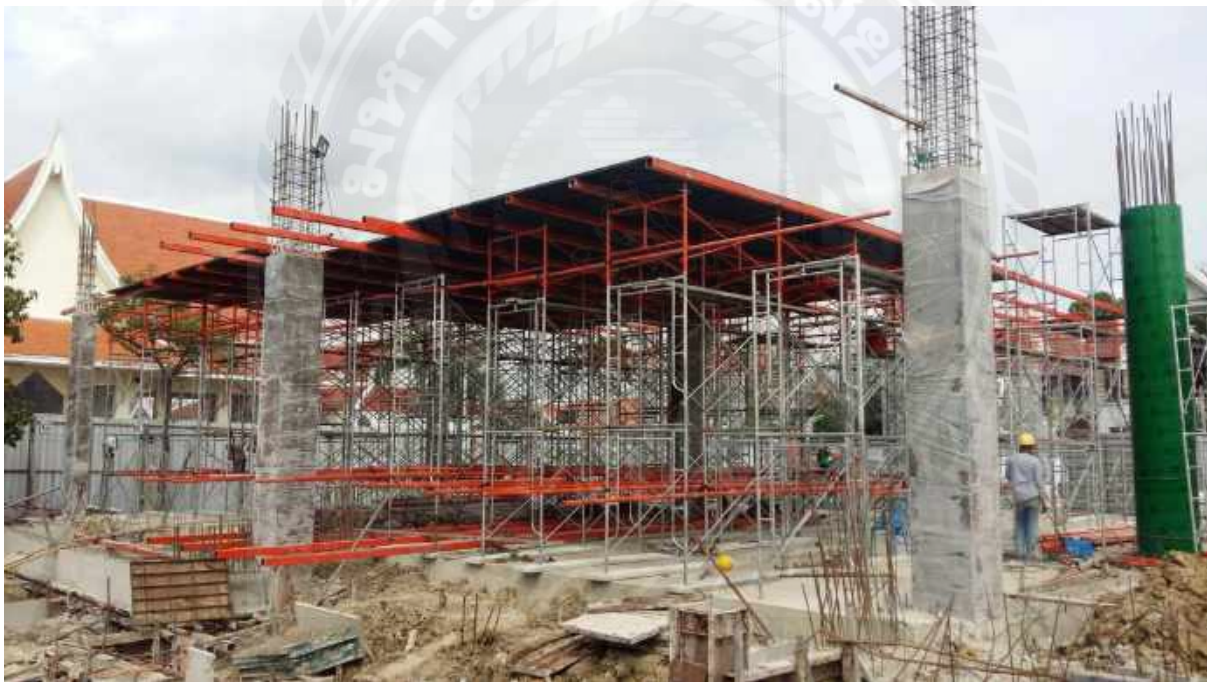
รูปที่ 4.4 การตั้งนั่งร้าน โดยใช้ U Head และ Jack Base ปรับระดับ
