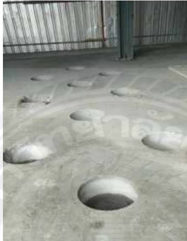
รูปที่ 4.7 รูเจาะคอนกรีตโดยวิธี Coring
