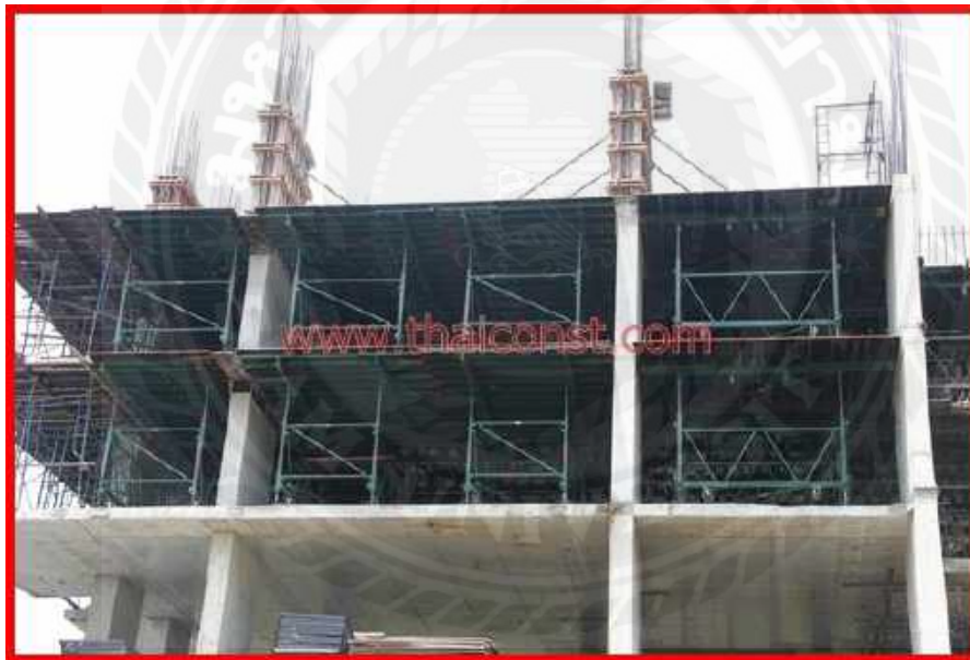
รูปที่ 4.6 การใช้แบบ Table Form เป็นท้องพื้น Post Tension
