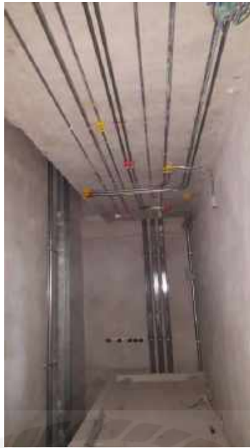
รูปที่ 5 การติดตั้งรางเดินสายไฟเข้าแผงไฟฟ้าย่อย
