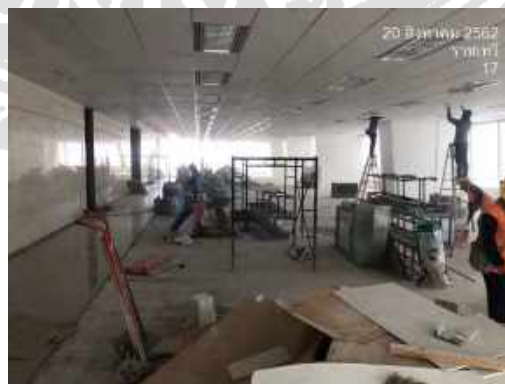
รูปที่ 3.5 ติดตั้งอุปกรณ์ไฟฟ้าภายในชั้นสำนักงาน
