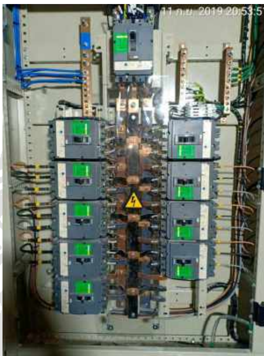
รูปที่ 4.15 แผงไฟฟ้าย่อย
