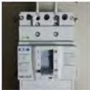
รูปที่ 7 เซอร์กิตเบรกเกอร์เมนของแผงไฟฟ้าย่อย
