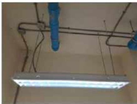
รูปที่ 4.18 การติดตั้ง โคมตะแกรง (Fin Louver Type)
