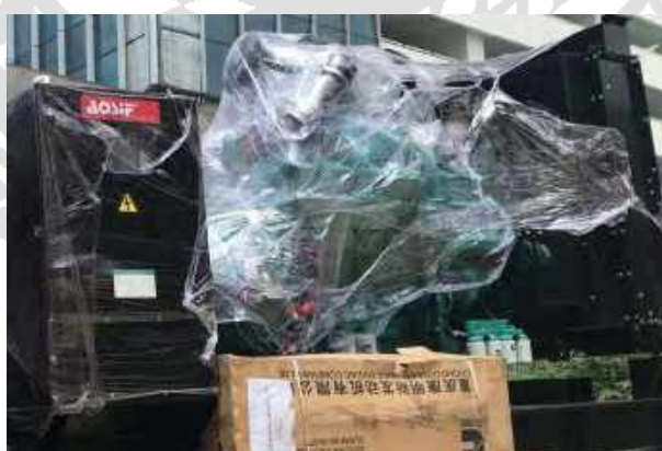
รูปที่ 4.13 เครื่องกำเนิดไฟฟ้า (Generator)
