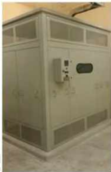
รูปที่ 4.5 หม้อแปลงไฟฟ้า
