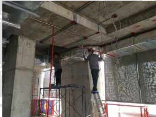
รูปที่ 3.4 เดินท่อร้อยสายไฟฟ้า
