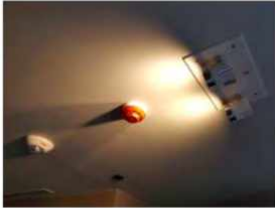
รูปที่ 4.36 ลักษณะแสงสว่างของไฟฉุกเฉิน
