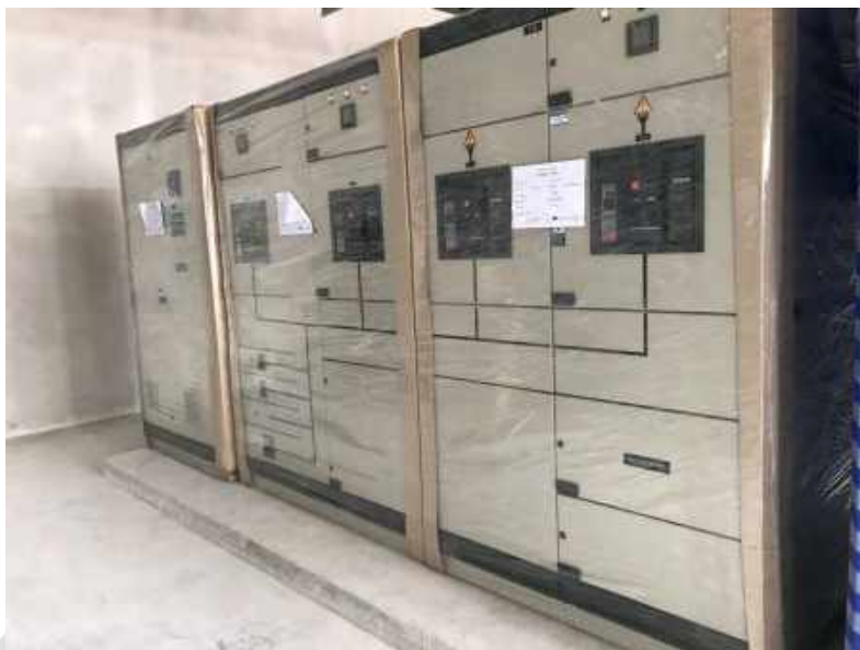
รูปที่ 4.12 บริเวณห้องประจักษ์สำรอง ตู้ EMDB
