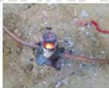
รูปที่ 4.27 การต่อหลักดินด้วยชุดเบ้าหลอมหลักดิน (Exothermic Welding)
