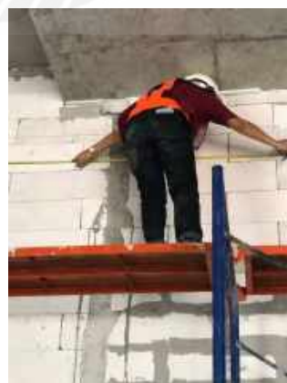
รูปที่ 11 วัดตำแหน่งติดตั้งอุปกรณ์
