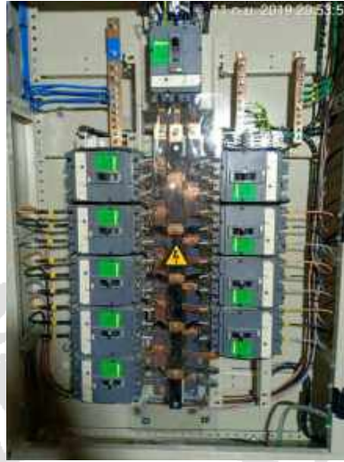
รูปที่ 3.3 แผงไฟฟ้าขนาดย่อย DB
