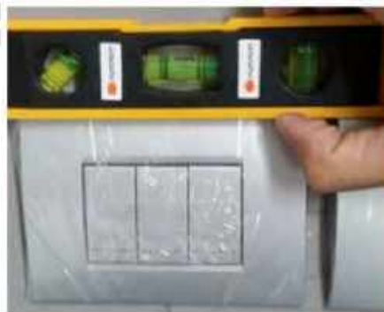
รูปที่ 4.22 การวัดระดับการติดตั้งสวิตช์ด้วยระดับน้ำ
