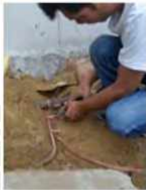
รูปที่ 4.28 การต่อสายเข้ากับโครงสร้างอาคาร
