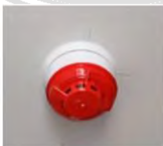
รูปที่ 4.34 อุปกรณ์ตรวจจับควัน (Smoke Detector)
