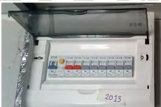
รูปที่ 4.16 คอนซูมเมอร์ยูนิต (Consumer Unit)
