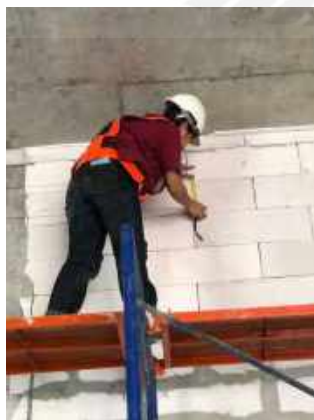
รูปที่ 11 วัดตำแหน่งติดตั้งอุปกรณ์
