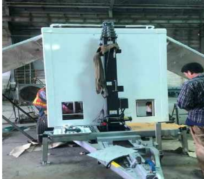
รูปที่ 4.7 การติดตั้งเสาส่งสัญญาณ
