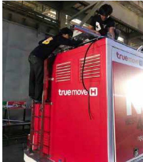
รูปที่ 4.3 ขณะกำลังติดตั้งเสาส่งสัญญาณ
