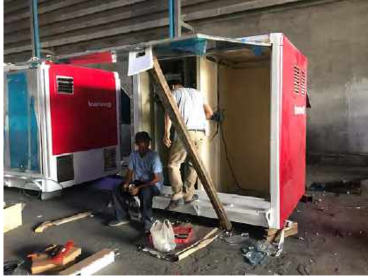
รูปที่ 4.5 การติดตั้งตู้ Rectifier
