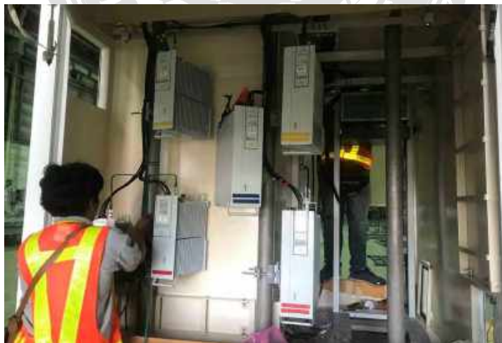
รูปที่ 4.8 การติดตั้งตู้ส่งสัญญาณ RRU.
