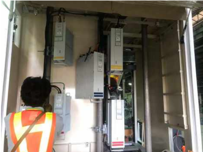
ติดตั้งตู้ RRU และใช้ระบบไฟ
