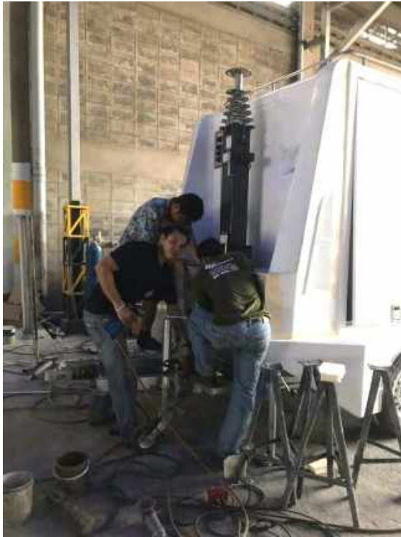
ติดตั้งเสาอากาศ
