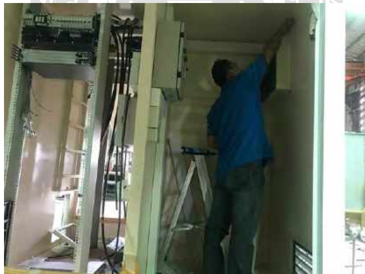
รูปที่ 4.6 ขณะเดินสายไฟภายในตู้
