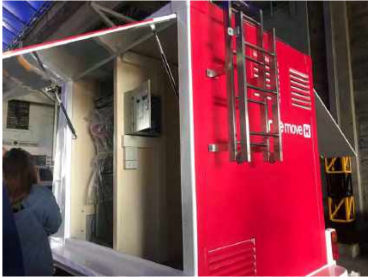
รูปที่ 2.8.4 บันไดซ่อมแซม
