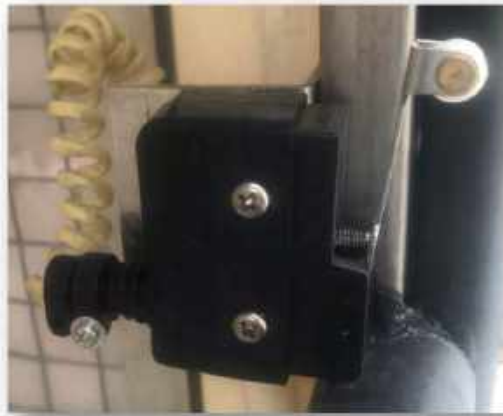
รูปที่ 2.6 ระบบแจ้งเตือนการเปิด/ปิดประตู Limit Switch
