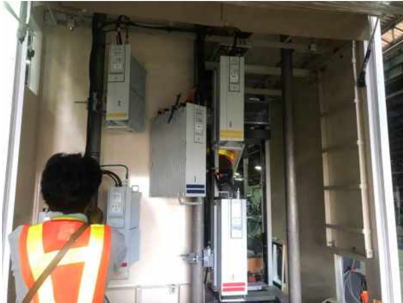
ติดตั้ง RRU และใช้ระบบไฟ
