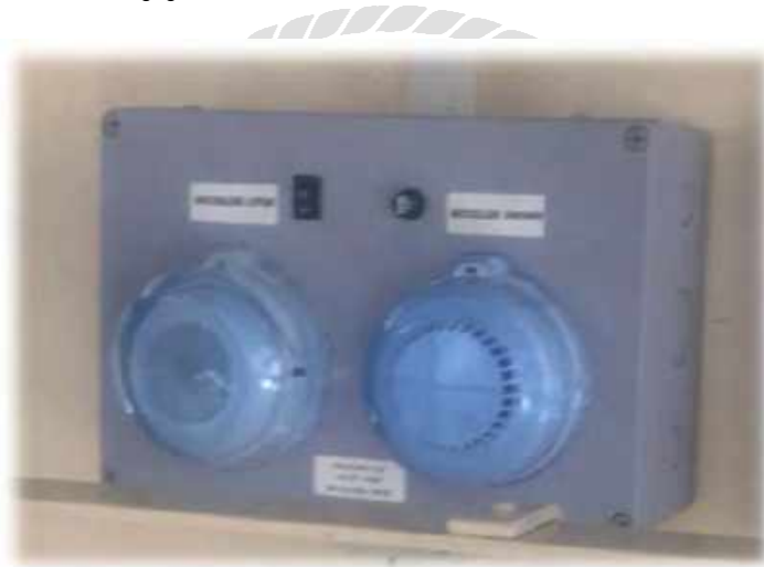
รูปที่ 2.5 ระบบแจ้งเตือนสัญญาณ Fire Alarm
