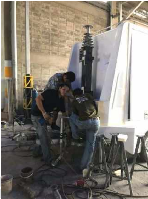
ติดตั้งเสาอากาศ
