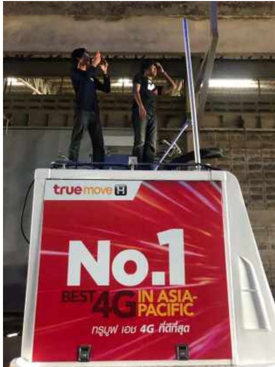
ขึ้นสำรวจเสาส่งสัญญาณ
