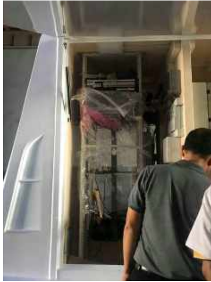
ติดตั้งเครื่อง Rectifier ภายในตัวรถ
