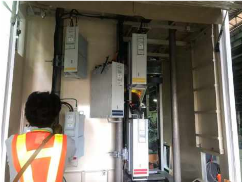
ติดตั้งตู้ RRU และเข้าระบบไฟ
