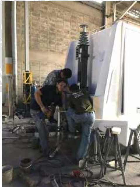
ติดตั้งเสาสัญญาณ
