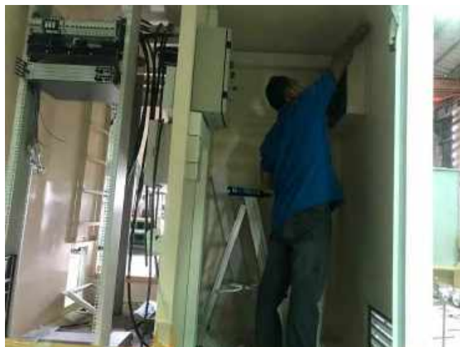
รูปที่ 4.8 ขณะเดินสายไฟภายในตัวรถ
