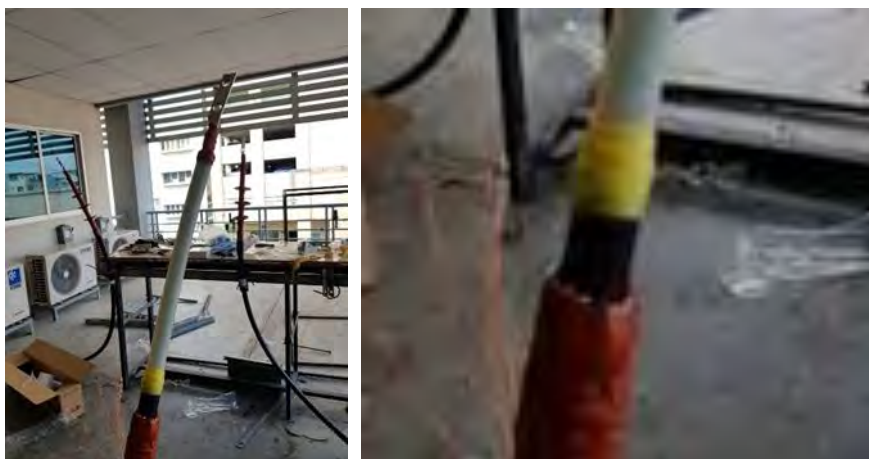
รูปที่ 4.12 พันเทป Yellow Mastic
