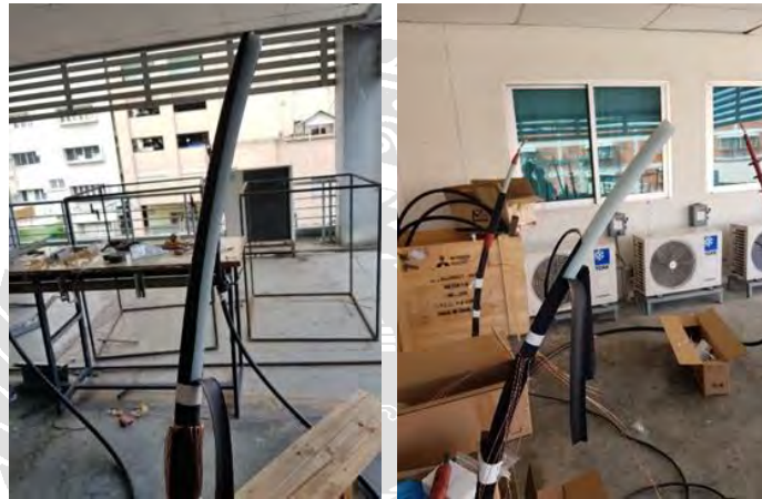
รูปที่4 ปลอกฉนวน ชั้นSemi ออก วัดระยะห่างจากขอบที่ถูกตัด ขึ้นมา 4 cm. และพันเทปเป็นจุดมาร์ก ระยะ โดยการปลอกจะทำการวางมือกรีดลงเบาๆ
