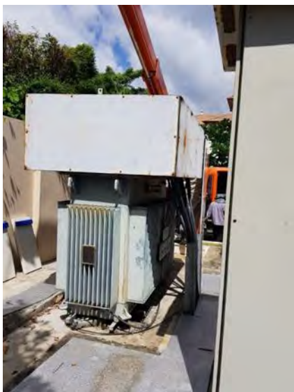
รูปที่ 3 ติดตั้งหม้อแปลง(Transformer) เพื่อแปลงไฟแรงดันกลางให้เป็นแรงดันต่ำจ่ายให้ตู้ MDB
