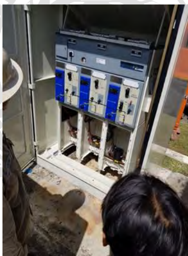
รูปที่ 2 ติดตั้งตู้ริงเมนยูนิต(RMU) เพื่อทำหน้าที่เป็นอุปกรณ์ในการตัดต่อวงจรไฟฟ้าที่เชื่อมต่อไปยังหม้อแปลง
