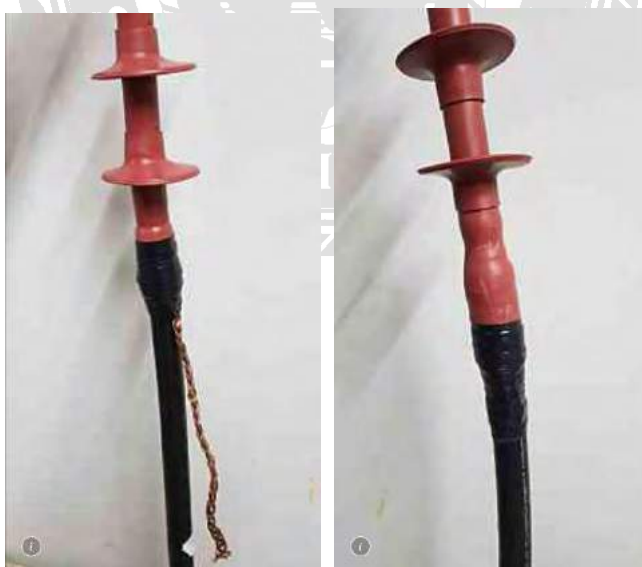
รูปที่ 4.15 การทำสายกราวด์
