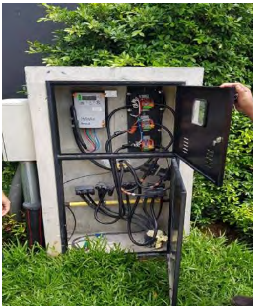
รูปที่ 5 ติดตั้งมิเตอร์(Meter) เพื่อทำหน้าที่คำนวณโหลด
