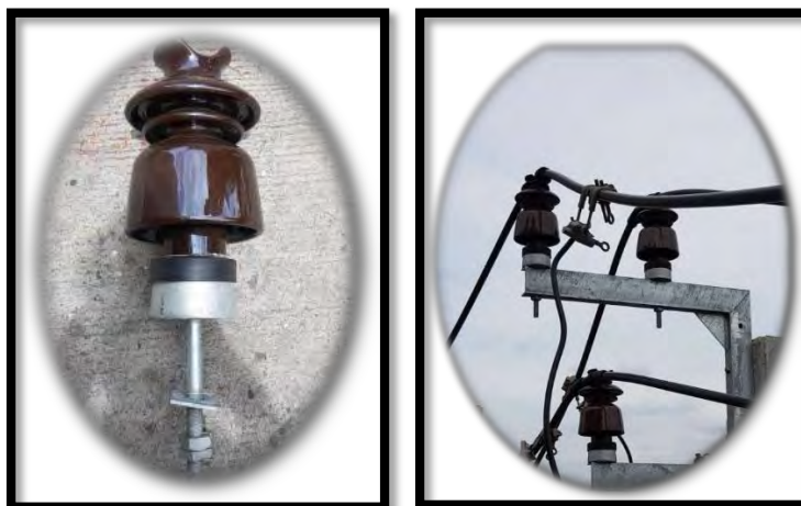
รูปที่ 2.6 ลูกถ้วยชนิด Pin Post
