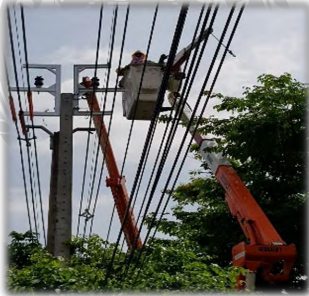
รูปที่ 2.1 สายไฟฟ้าแรงดันกลาง
