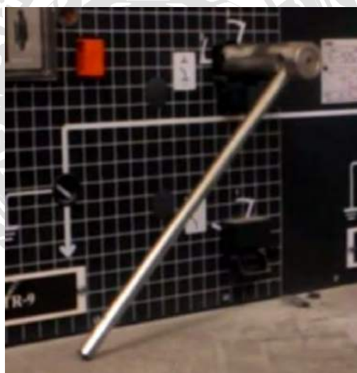
รูปที่ 7 Hand Block เป็นอุปกรณ์ที่ใช้ในการปลดสับสวิทช์ริงเมนยูนิท(RMU)
