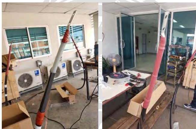
รูปที่ 9 สวมท่อหด โดยการสวมท่อหดชั้นที่ 1 หรือชั้น Sami โดยเว้นระยะห่างจากขอบชั้น Jacket ที่ถูกตัดขึ้นมา 0.5 cm. และใช้โบเวอร์เป่าเพื่อทำความร้อน ส่วนชั้นที่ 2 หรือชั้น Jacket ให้สวมทับเทป Red Mastic โดยปิดทับเสมอกับขอบด้านบนและด้านล่างและใช้โบเวอร์เป่าเพื่อทำความร้อน
