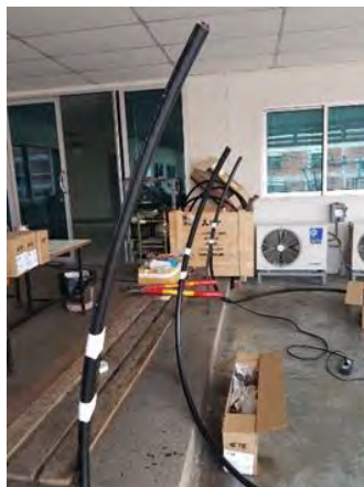
รูปที่ 1 จัดเตรียมสายไฟขนาด 24 kvA มายึดกับฐานที่มั่นคง เพื่อเตรียมการปอกสาย และสร้างหัว
