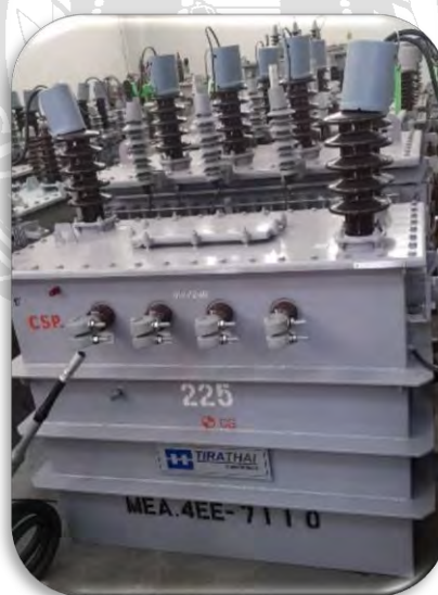
รูปที่ 2.3 หม้อแปลง Transformer
