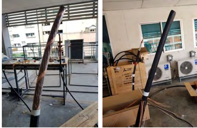
รูปที่3 จะพบพลาสติกใสที่หุ้มอยู่ ให้ทำการแกะ พลาสติกส่วนนี้ออก แล้วจึงทำการตัดทองแดงชนิดแผ่นทิ้ง ให้เหลือไว้แต่เพียงทองแดงชนิดเส้น และพับลง 3 ข้าง แบ่งเท่าๆกัน
