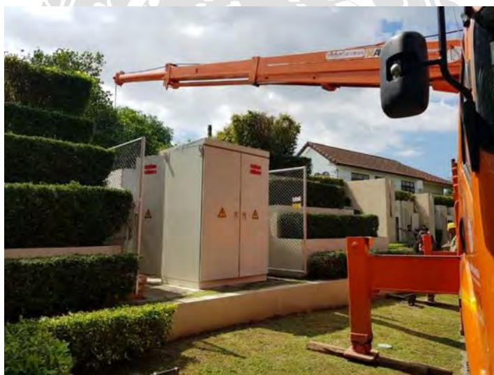
รูปที่ 4 ติดตั้งตู้ MDB เพื่อตัดต่อวงจรกรณีเกิดการลัดวงจรในด้านแรงต่ำ แล้วจ่ายไฟเข้ามิเตอร์
