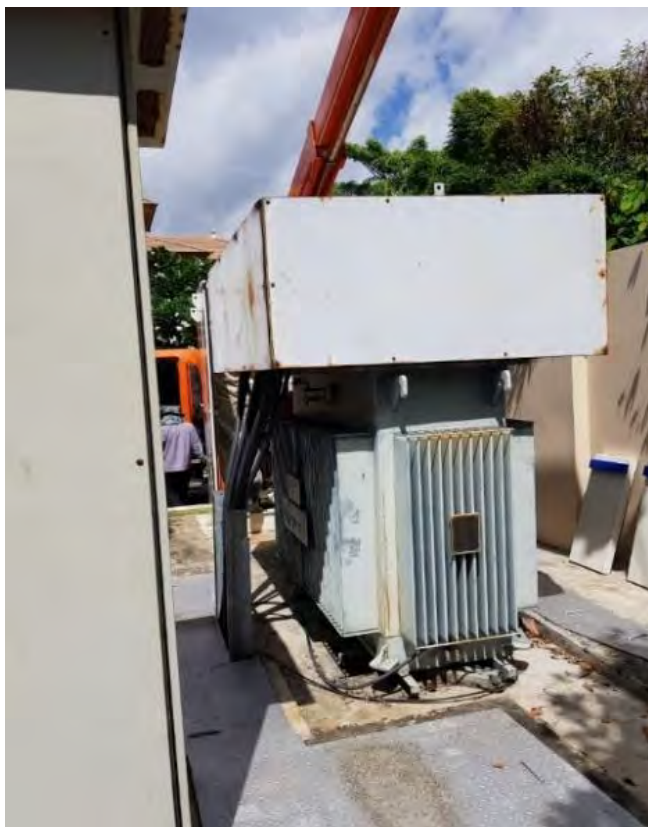
รูปที่ 4.3 หม้อแปลง (Transformer)
