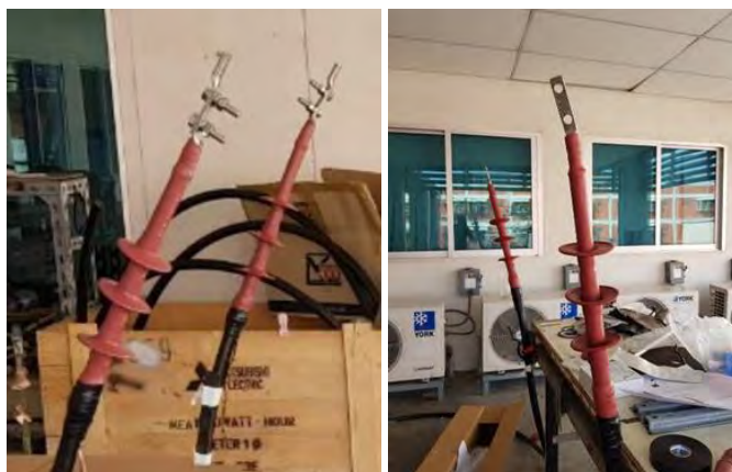
รูปที่ 9 สวมท่อหด โดยการสวมท่อหดชั้นที่ 1 หรือชั้น Sami โดยเว้นระยะห่างจากขอบชั้น Jacket ที่ถูกตัดขึ้นมา 0.5 cm. และใช้โบเวอร์เป่าเพื่อทำความร้อน ส่วนชั้นที่ 2 หรือชั้น Jacket ให้สวมทับเทป Red Mastic โดยปิดทับเสมอกับขอบด้านบนและด้านล่างและใช้โบเวอร์เป่าเพื่อทำความร้อน
