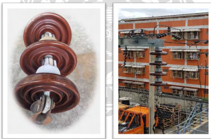
รูปที่ 2.7 ลูกถ้วยแขวนชนิด Suspension insulator
