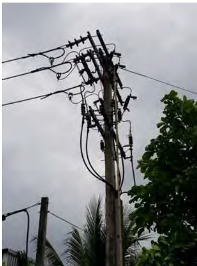
รูปที่ 1 ติดตั้งเสา สายเคเบิล ครอบพิวส์ ที่ riser pole เพื่อส่งจ่ายกระแสไฟฟ้าไปยังตู้ริงเมนยูนิต(RMU)
