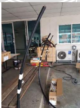
รูปที่ 4.5 เตรียมสายไฟขนาด 24 kV
