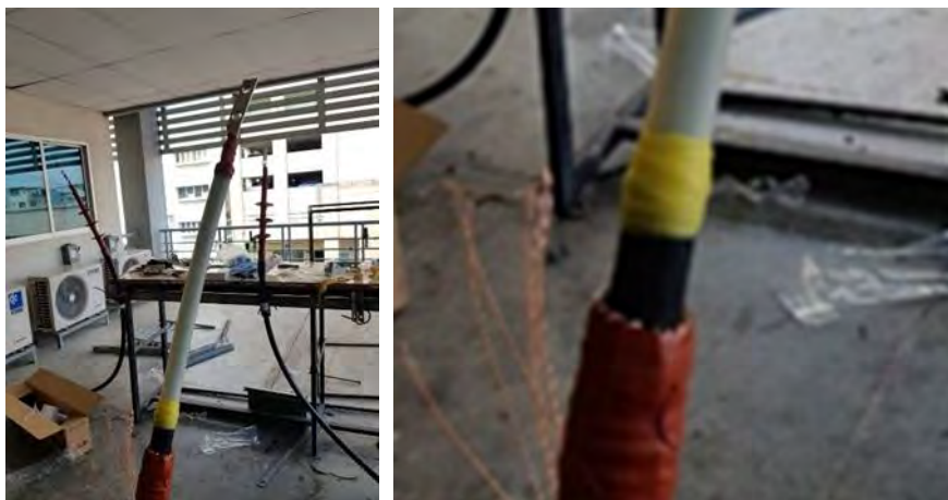
รูปที่ 8 พันเทป Yellow Mastic ในการลบบวมจะต้องพันเทป Yellow Mastic ทับชั้น Sami 2 cm. และทับชั้น Cross Link 1 cm.
