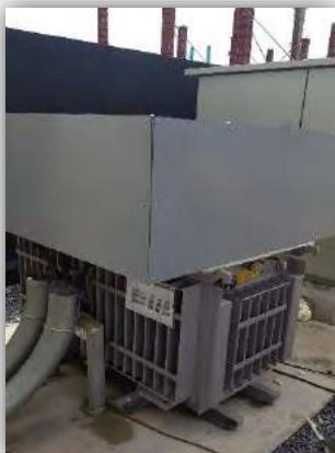
รูปที่ 2.14 หม้อแปลงติดตั้งพื้นดิน
