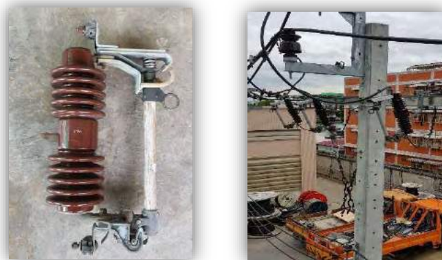
รูปที่ 2.4 Drop Fuse
