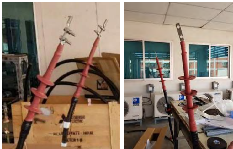
รูปที่ 4.14 การติดตั้ง Skirts
