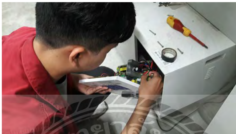
รูปที่ 6.15 ทำการเปลี่ยนชุดควบคุมของ Central Battery
