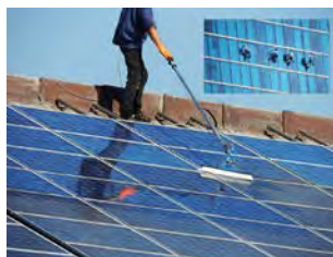
รูปที่ 4.1 การทำความสะอาดแผงพลังงานแสงอาทิตย์
