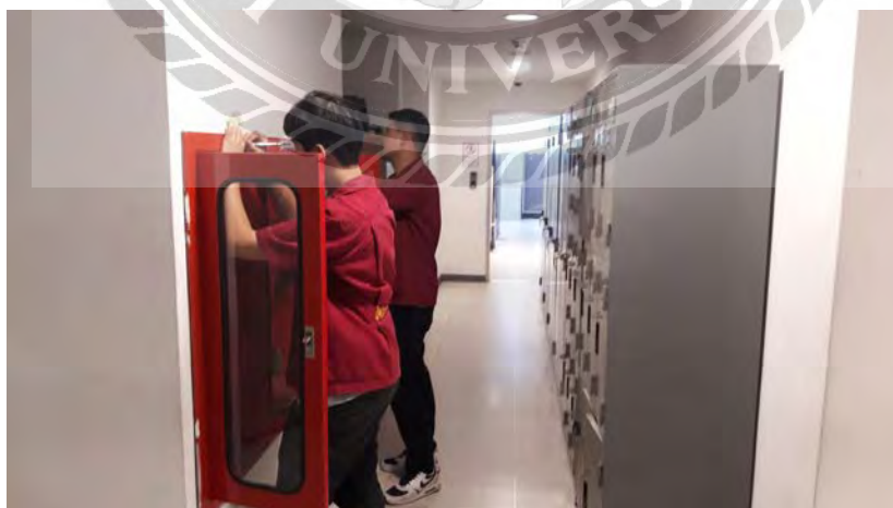
รูปที่ 6.16 ทำการตรวจเช็คระบบ Fire Hose
