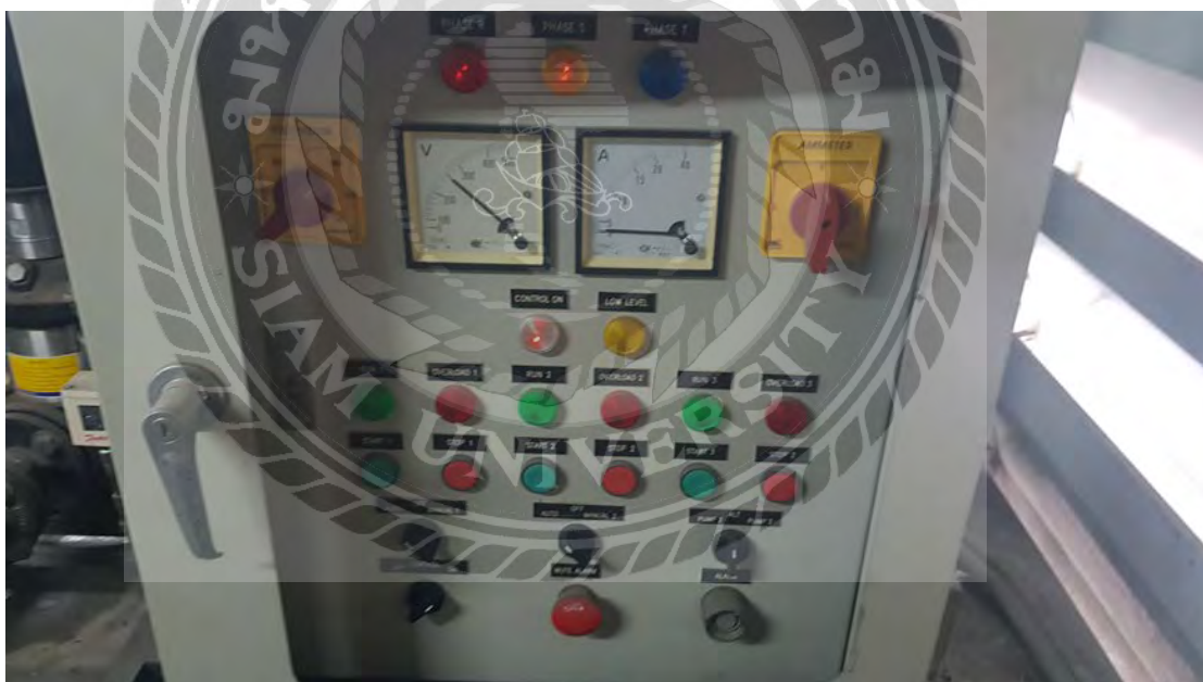
รูปที่ 6.20 ตรวจสอบตู้ควบคุมการทำงานมอเตอร์ปั้มน้ำ (Booster Pump)
