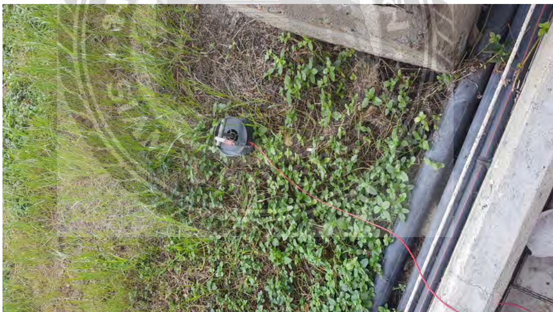
รูปที่ 6.24 การต่อสายไฟของเครื่อง Earth Ground Tester เข้ากับหลักดิน
