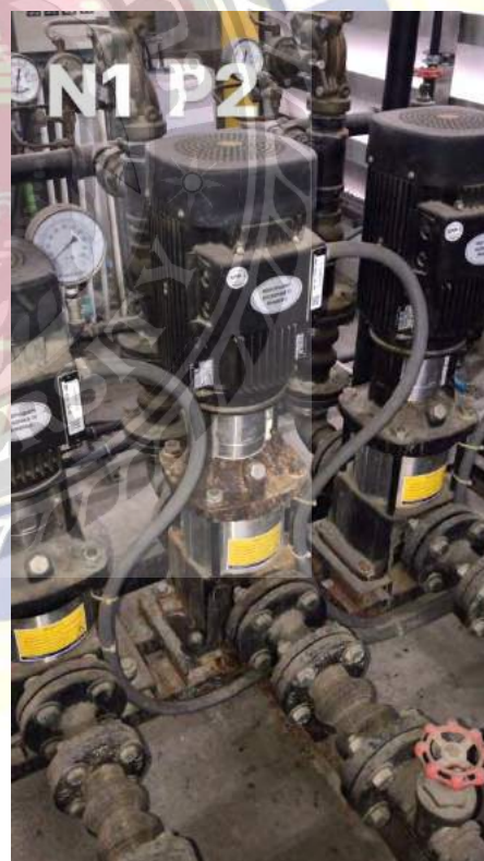
งานตรวจสอบมอเตอร์ปั๊มน้ำจ่ายเย็น
