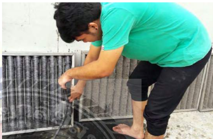
รูปที่ 4.2 การทำความสะอาดแผงกรองอากาศ (Air Filter)
