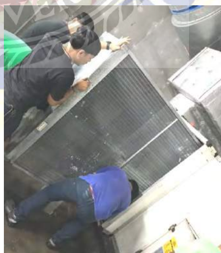
รูปที่ 4.3 การถอดชุดลดความชื้นด้วยฮีทไพป์ (Heat Pipe)
