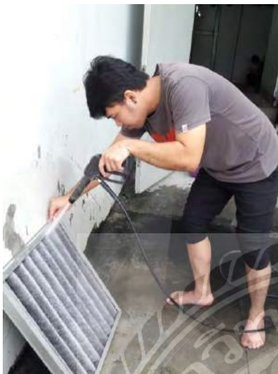
รูปที่ 4.2 การทำความสะอาดแผงกรองอากาศ (Air Filter)
