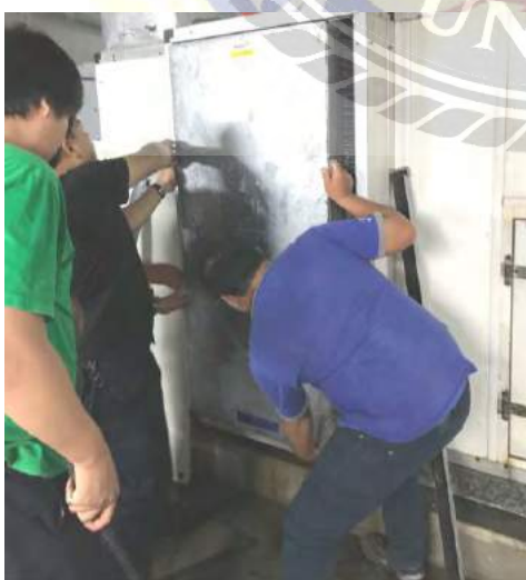
รูปที่ 4.3 การถอดชุดลดความชื้นด้วยฮีทไพป์ (Heat Pipe)
