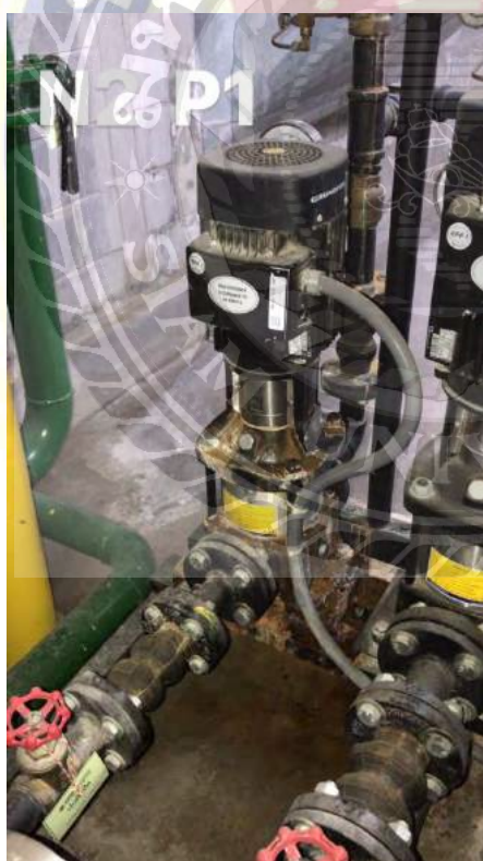
งานตรวจสอบมอเตอร์ปั๊มน้ำจ่ายเย็น
