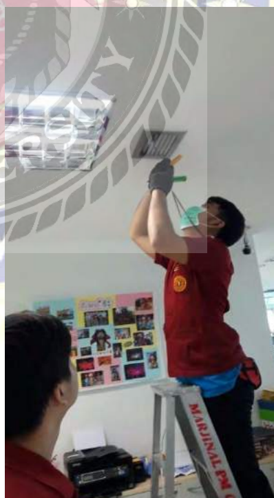
งานตรวจสอบค่าอุณหภูมิของลมที่ผ่านการควบคุมการทำความเย็น
