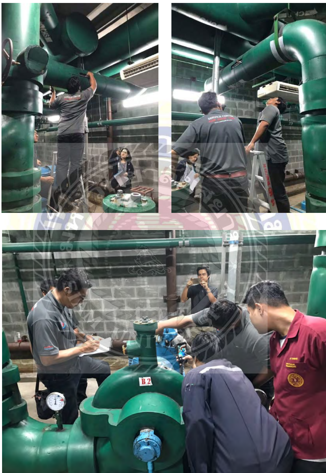
งานตรวจสอบท่อส่งจ่ายน้ำเย็น
