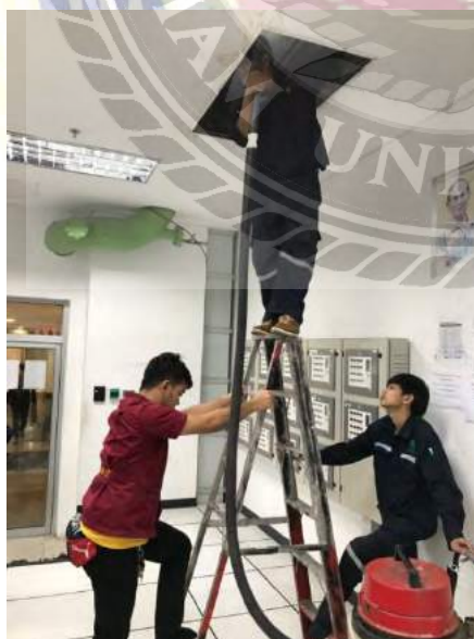
งานกำจัดน้ำที่เกิดการกลั่นตัวนอกระบบ (Condensate Water)
