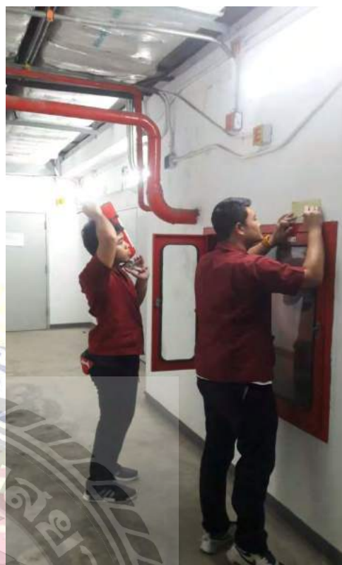
การตรวจสอบท่อสายยางดับเพลิง (Fire Hose)
