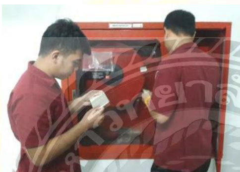
การตรวจสอบท่อสายยางดับเพลิง (Fire Hose)
