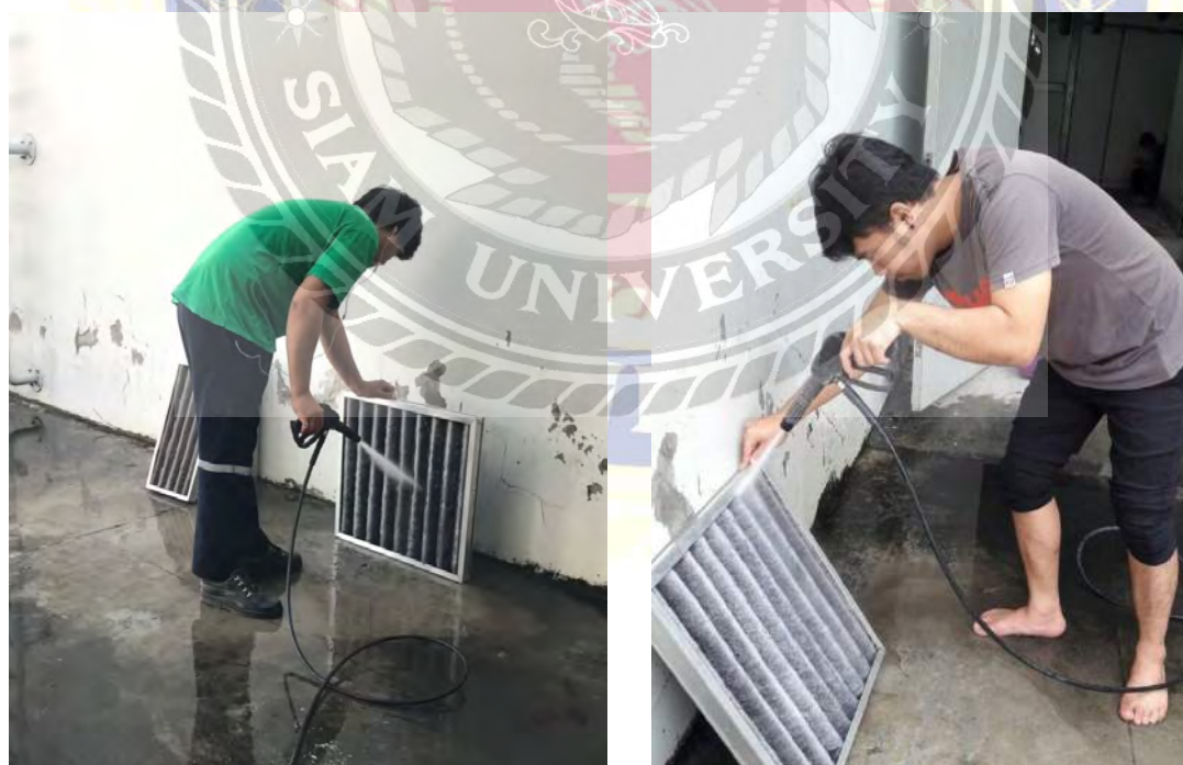
งานทำความสะอาดแผงกรองอากาศ (Air Filter)
