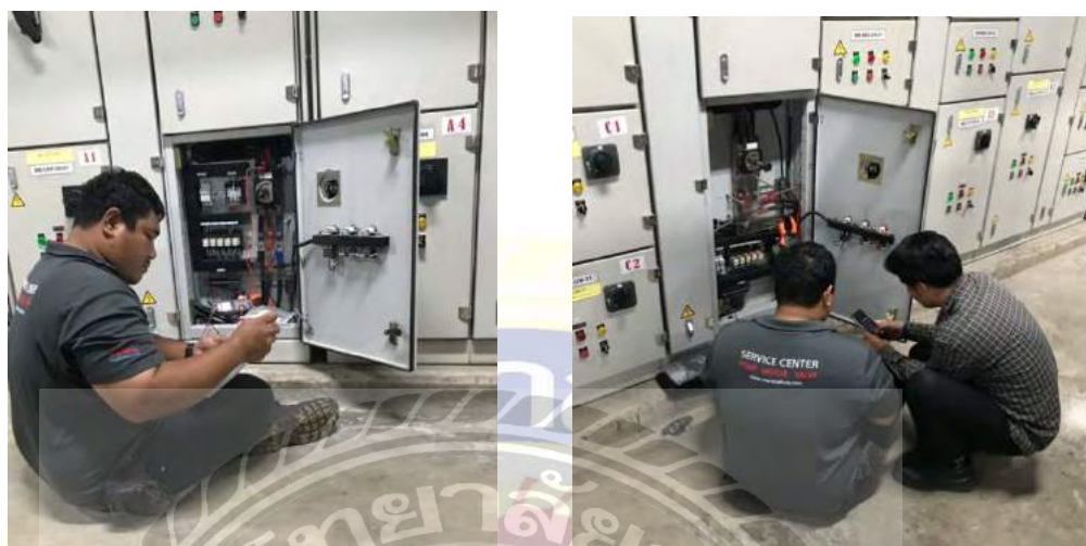
งานตรวจสอบเครื่องควบคุมระบบไฟฟ้า
