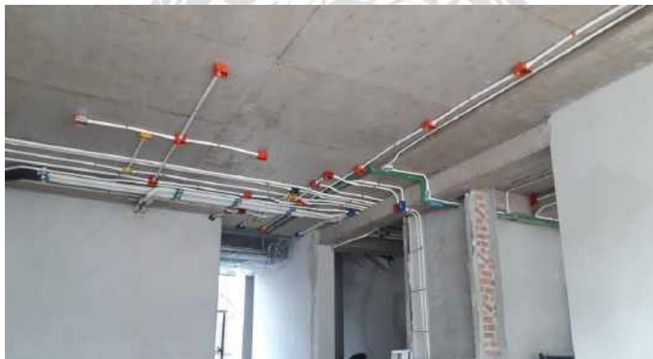
รูปที่ 4.10 ภาพการทำงานร้อยท่อสายไฟฟ้าบนฝ้า
