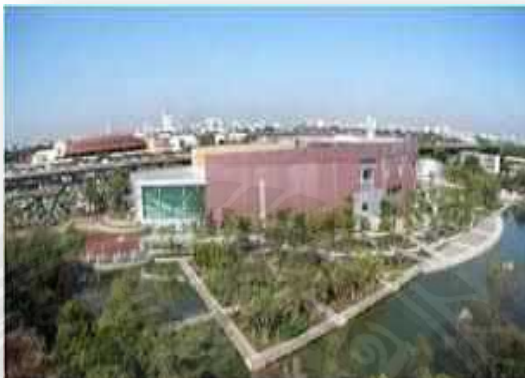
รูปที่ 1.1 โรงควบคุมคุณภาพน้ำบางซื่อ ศูนย์ข้อมูลกลาง
