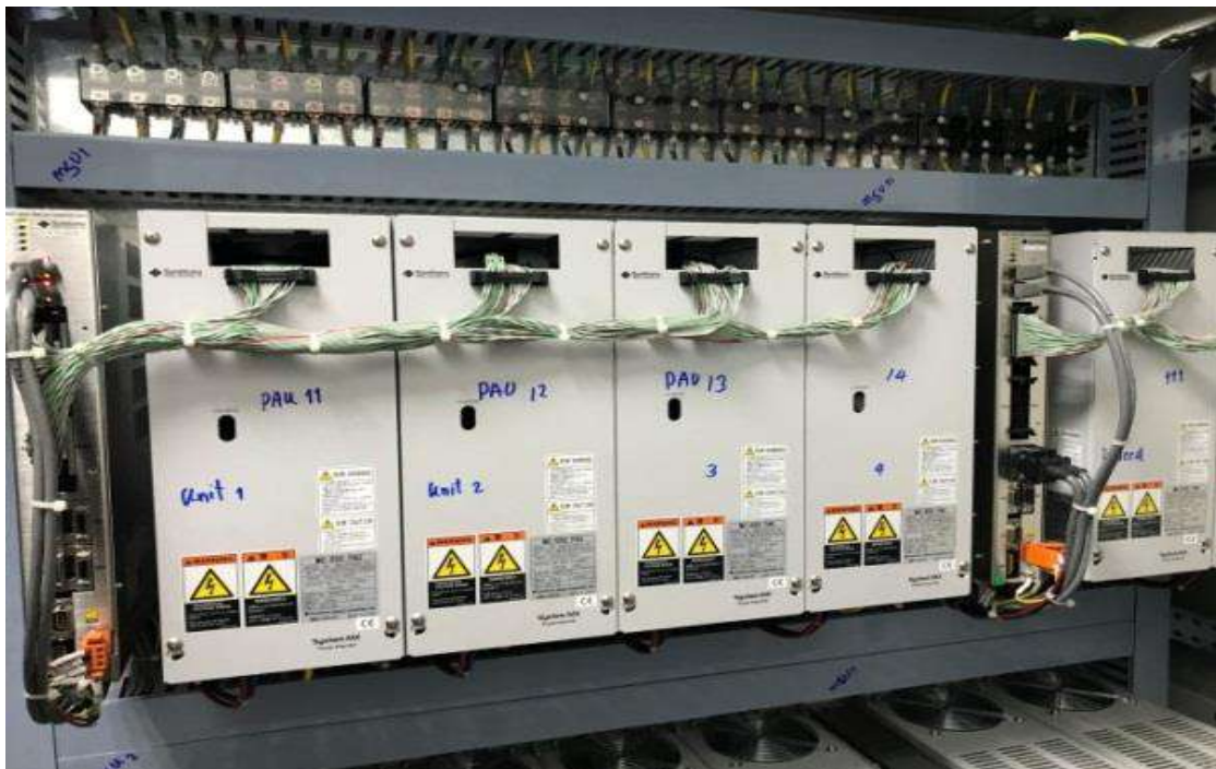
รูปที่ 4.12 ตู้ไฟควบคุม
