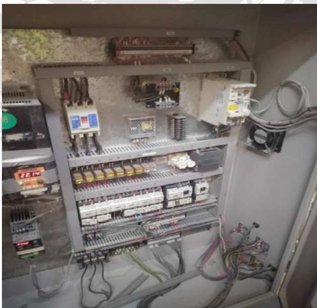
รูปที่ 4.11 ตู้ไฟควบคุม
