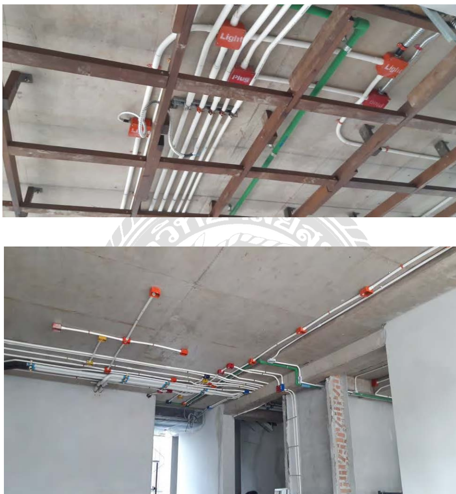
รูปที่ 4.10 ภาพการทำงานร้อยท่อสายไฟฟ้าบนฝ้า
