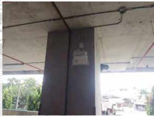
รูปที่3.4 ไฟฉุกเฉิน ( Emergency light )
