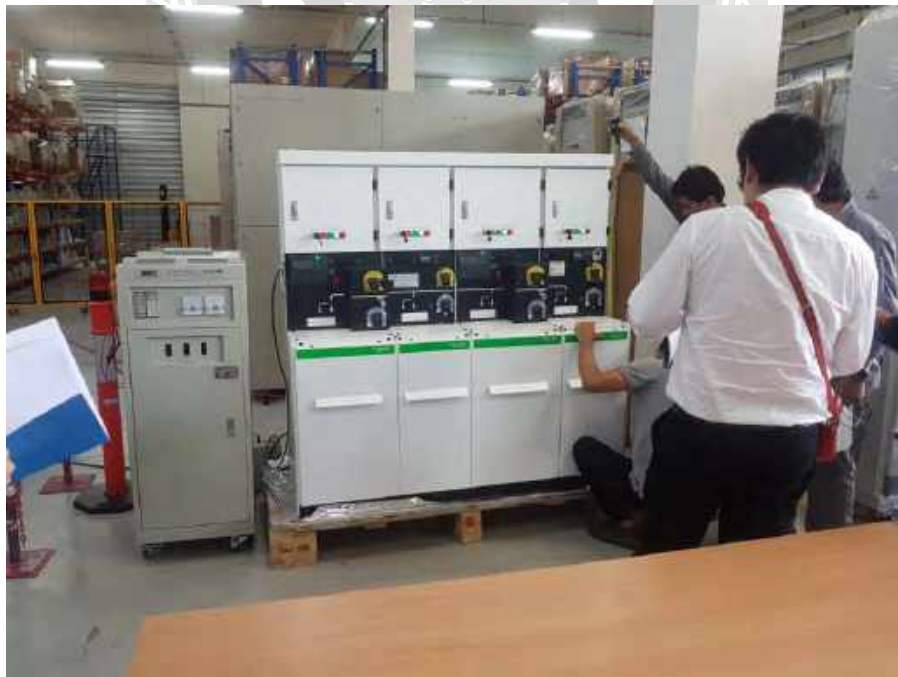
รูปที่ 4.6 จ่ายไฟจริงเข้าสวิทซ์เกียร์
