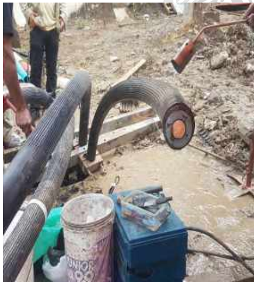
รูปที่ 4.34 ขณะทำการปลดสายไฟ ก่อนทำการฝังลงใต้ดิน
