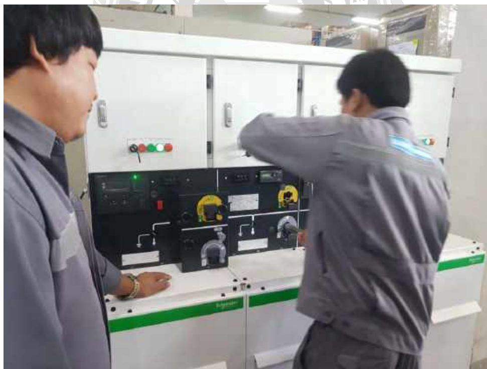
รูปที่ 4.4 ตรวจสอบระบบไฟของตู้สวิตช์เกียร์
