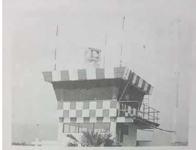
รูปที่ 2.17 ลักษณะการติดตั้งไฟหมุนบอกตำแหน่ง ( Aerodrome Beacon )
