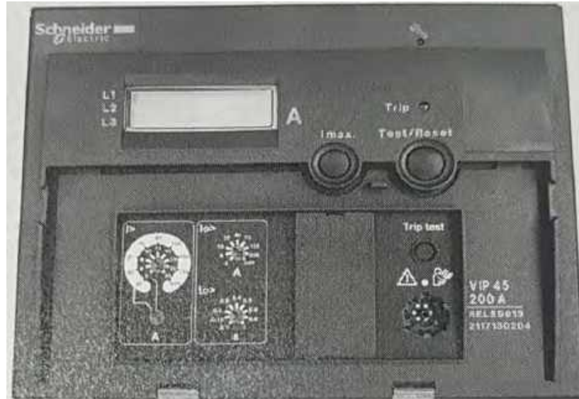
รูปที่ 4.11 Protection Relay
