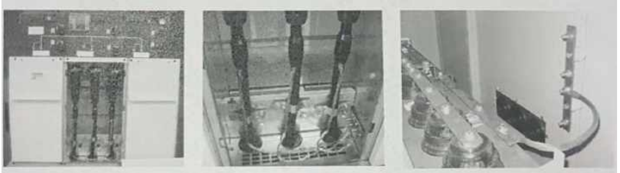
รูปที่ 4.26 ตรวจสอบสายไฟเข้าสู่ตู้สวิตช์เกียร์
