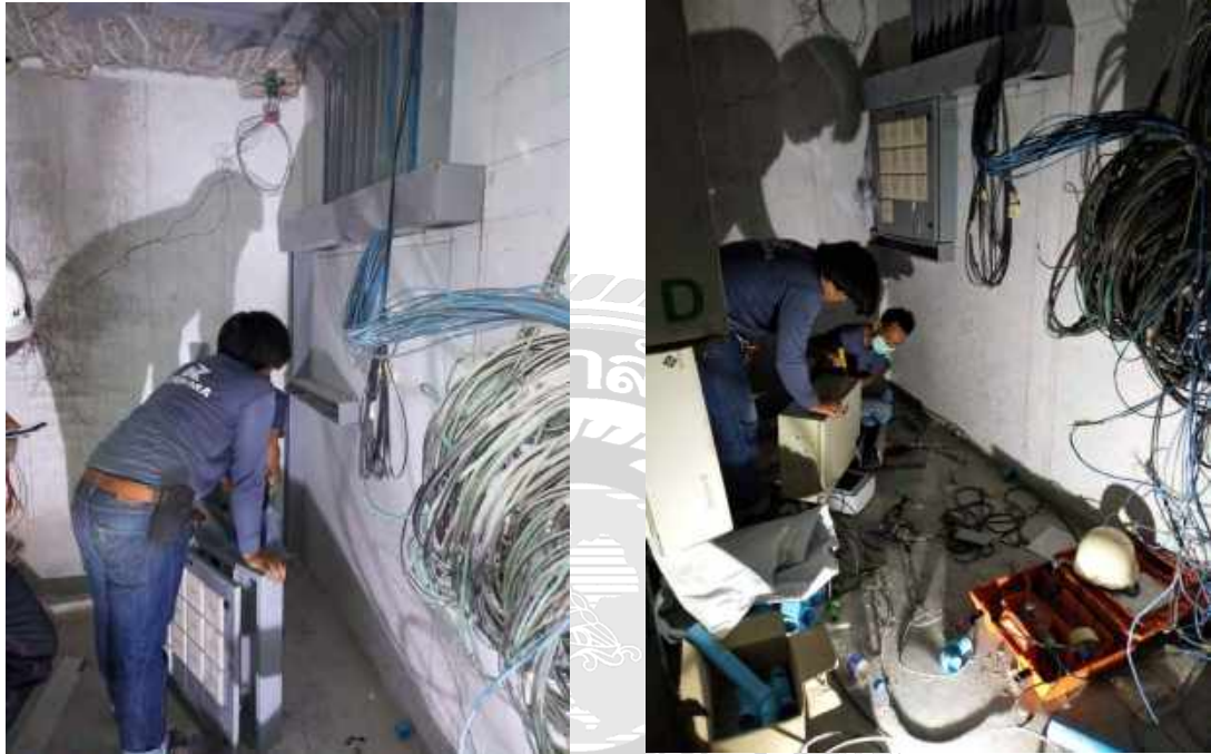
รูปที่ 4.14 การติดตั้งและวางตำแหน่งของตู้ไฟ
