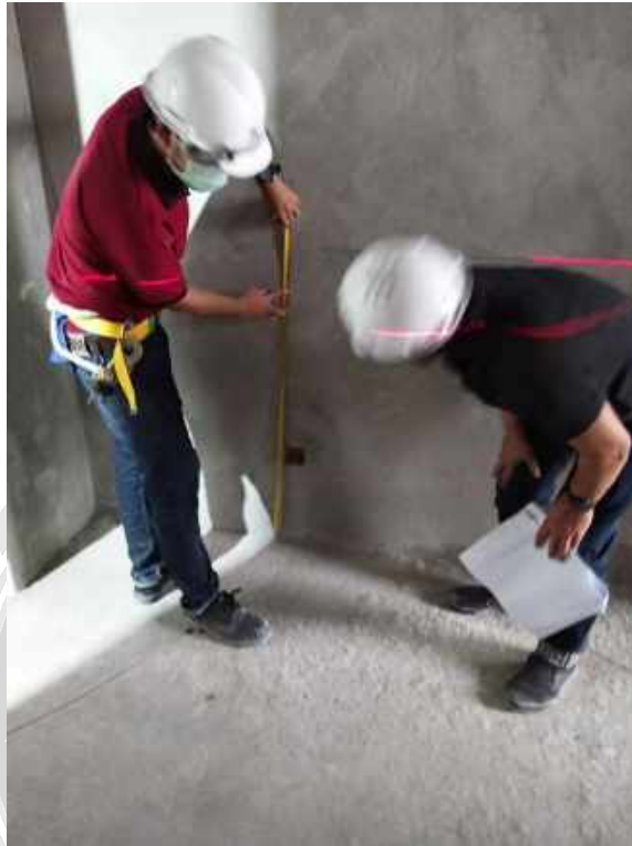
รูปที่ 4.3 การตรวจเช็คบล็อกไฟหลังงานเทพนัง
