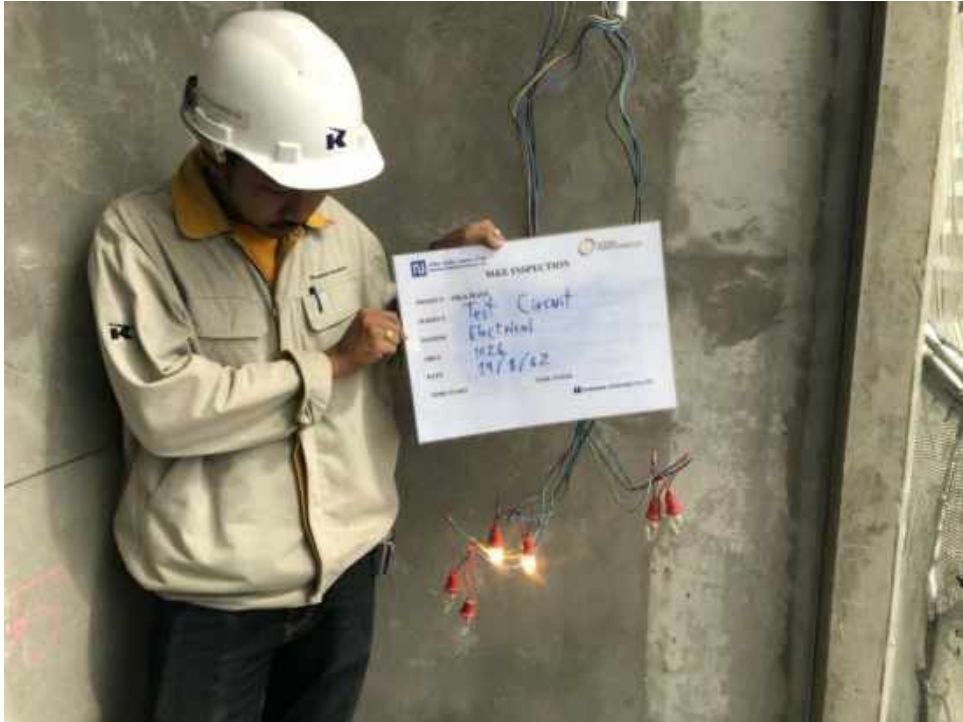
รูปที่ 5 การทดสอบวงจร
