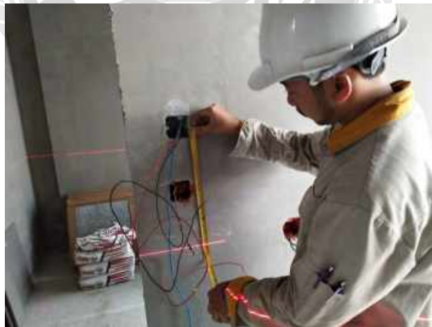
รูปที่ 4.5 การตรวจบล็อกไฟที่มีข้อผิดพลาด
