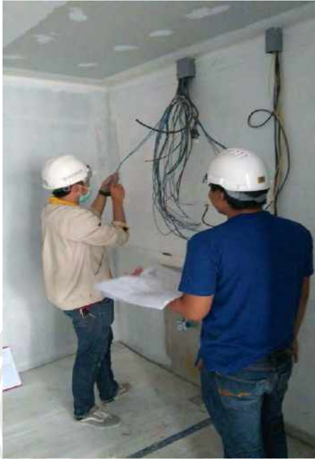
รูปที่ 3 การเช็คขนาดของสายไฟ
