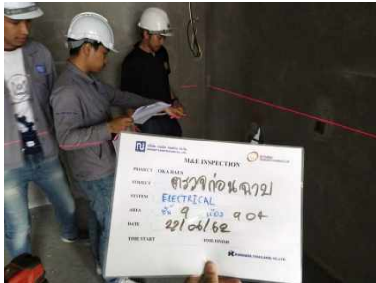
รูปที่ 4.4 การตรวจงานก่อนฉาบ
