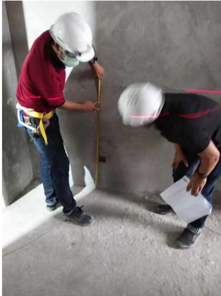
รูปที่ 2 การเช็คตำแหน่งบล็อกไฟ
