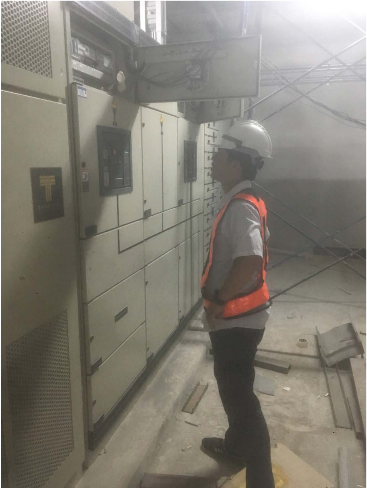
รูปที่ 8 การตรวจเช็ค อุปกรณ์ ตู้ MDB
