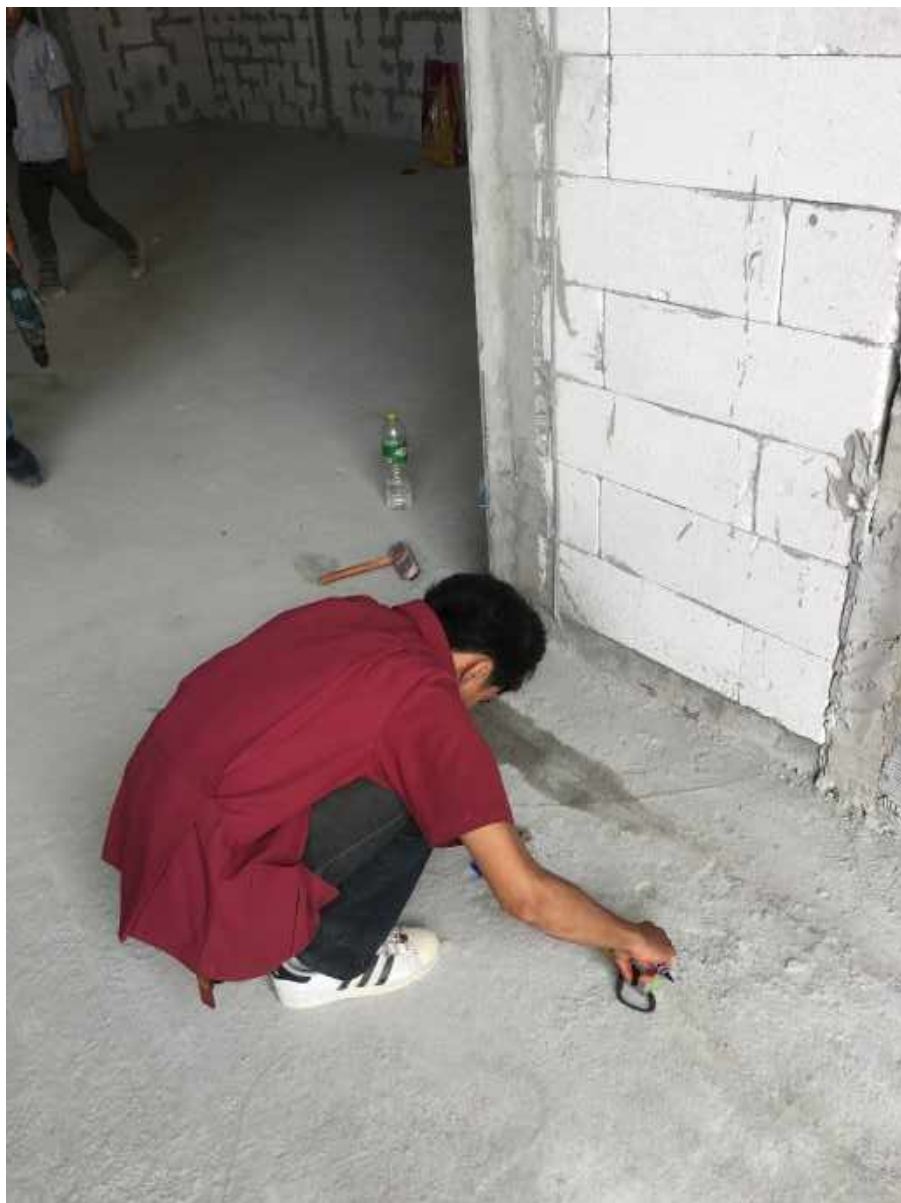
รูปที่.10วัดแทนที่ใช้วางตู้ MDB
