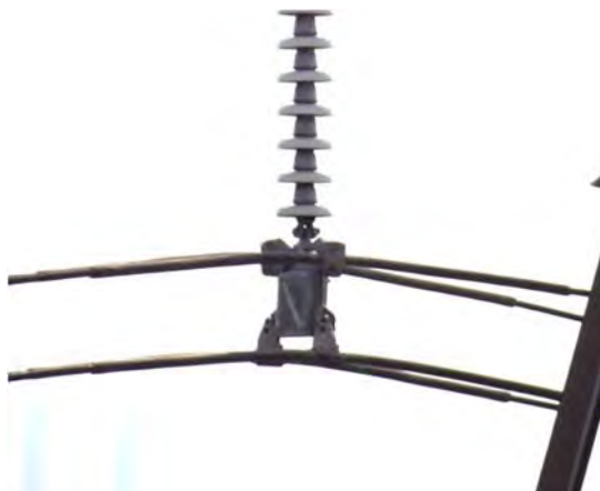
ภาพที่ 2-9 แคลมป์แขวนสาย (Suspension Clamp)
