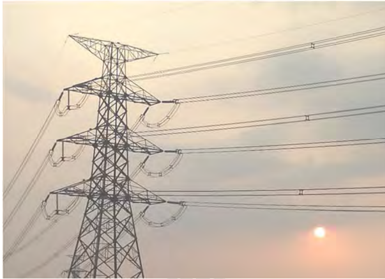
ภาพที่ 2-10 ลักษณะเสาโครงเหล็กสี่เหลี่ยมจัตุรัส
