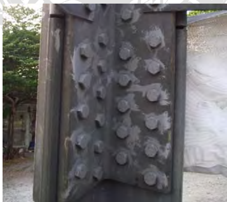
ภาพที่ 2-17 เหล็กstub (Stub)
