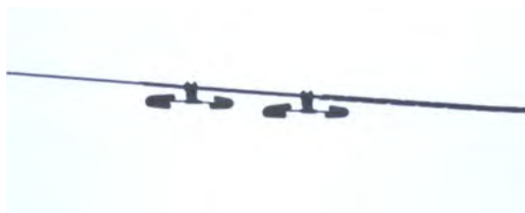
ภาพที่ 2-22 อุปกรณ์หน่วงการแกว่ง (Vibration Damper)
