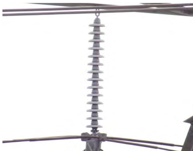
ภาพที่ 2-1 ลูกถ้วยกระเบื้องเคลือบ (Porcelain Insulators) 230 กิโลโวลต์
