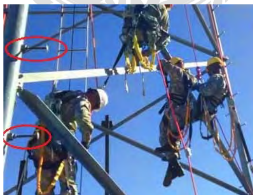
ภาพที่ 2-21 สเต็ปโบลท์ (Step Bolt)
