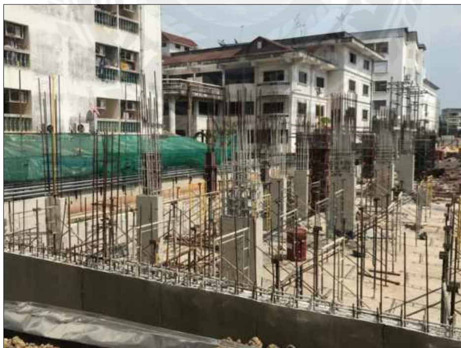
ภาคผนวกรูปที่ 8 ถอดแบบเสา
