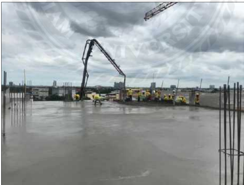
รูปที่ 4.3.22 การเทคอนกรีต(1)[4]
