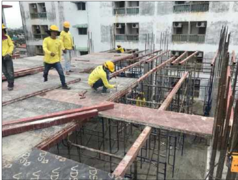
รูปที่ 4.3.3 ติดตั้งแบบหล่อท้องพื้น[3]
