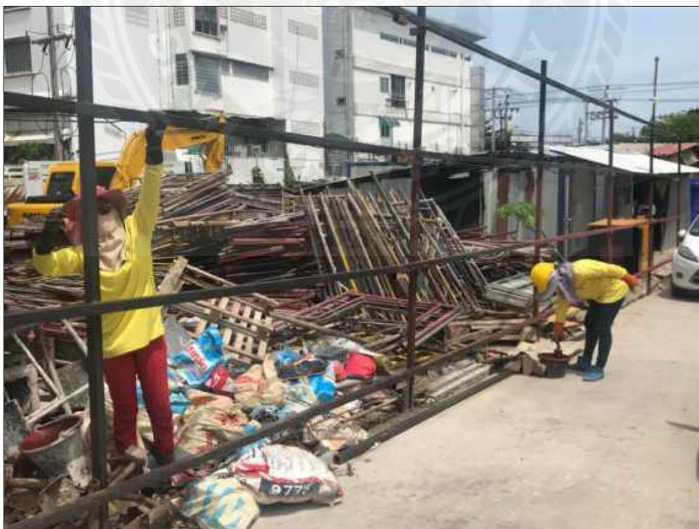
ภาคผนวกรูปที่ 22 เชื่อมโครงกันพื้นที่ก่อสร้าง
