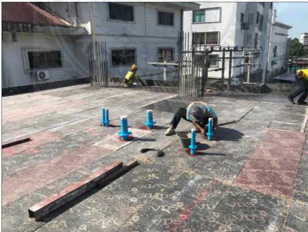
ภาพผนวกรูปที่ 12 ติดตั้งงานระบบก่อนเทพื้น
