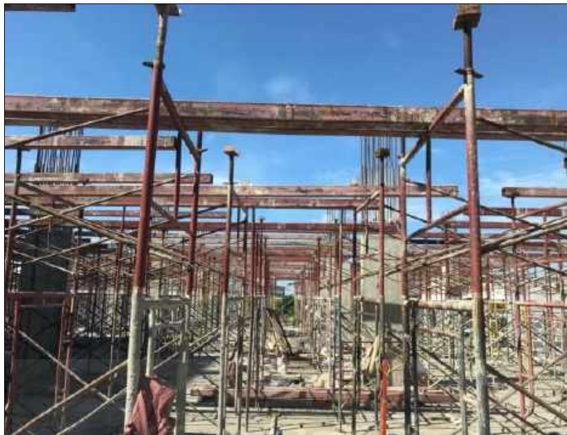
รูปที่ 4.3.1 ติดตั้งนั่งร้าน[4]
