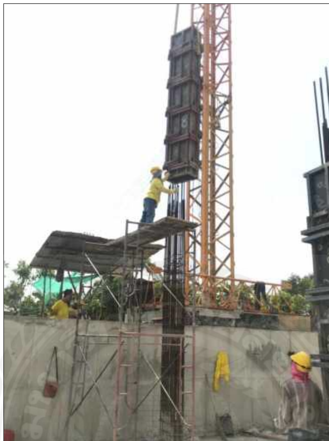
ภาคผนวกรูปที่ 7 เข้าแบบเสา
