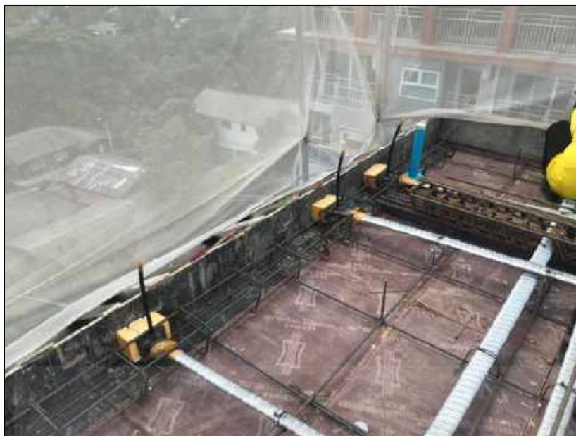
รูปที่ 4.3.13 ติดสมอซีด Tendon กับแบบข้างและติดตั้งเหล็กกันระเบิด(1)[4]
