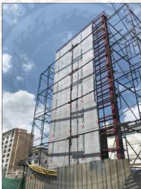
ภาคผนวกรูปที่ 27 ติดตั้งแผ่นคอมโพสิต
