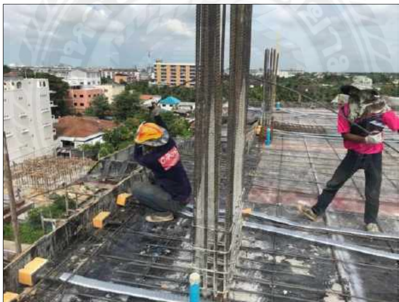
รูปที่ 4.3.10 สอดลวด PC Strand เข้าใน Corrugated sheath(2)[4]
