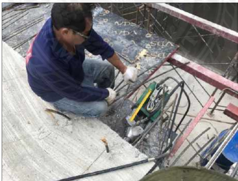
รูปที่ 4.3.26 การดึงลวดอัดแรงคอนกรีต(1)[4]
