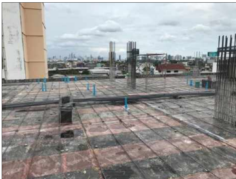
รูปที่ 4.3.5 การวางเหล็กเสริมล่าง[4]
