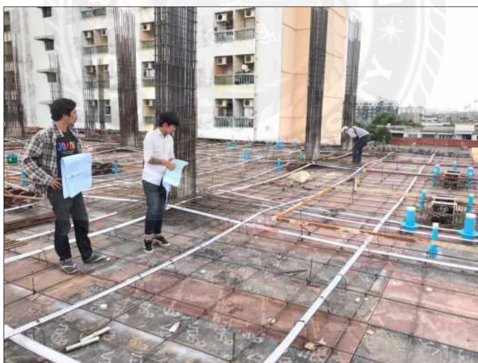
ภาคผนวกรูปที่ 18 ตรวจสอบแนวลาดสลิ้ง
