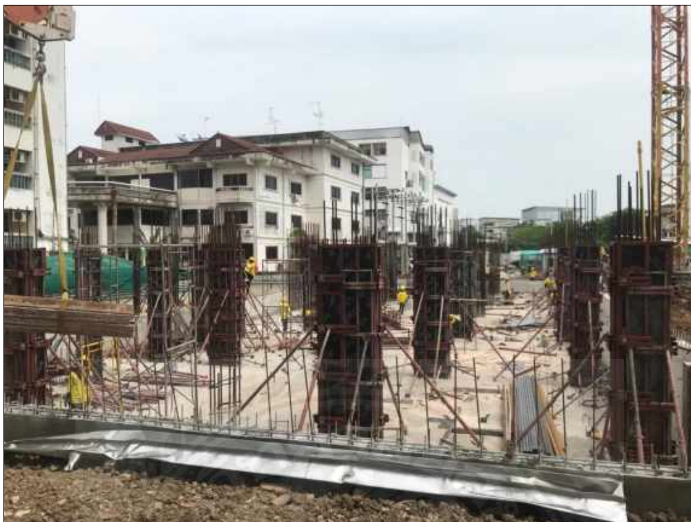
ภาคผนวกรูปที่ 3 เข้าแบบเสา
