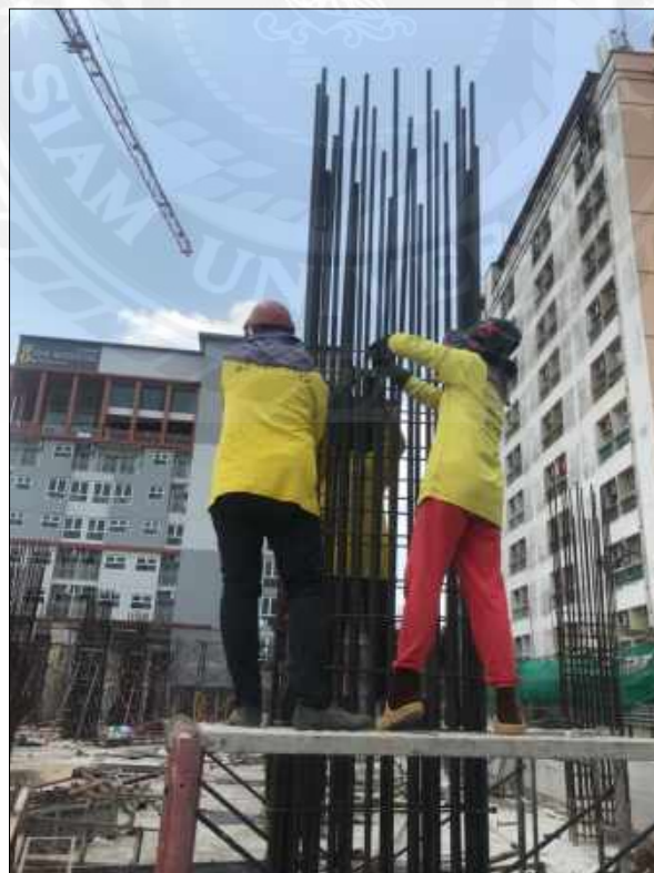
ภาคผนวกรูปที่ 6 ผูกเหล็กเสา
