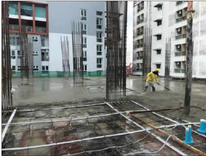
รูปที่ 4.3.23 การเทคอนกรีต(2)[4]
