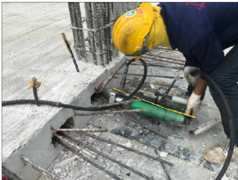
รูปที่ 4.3.27 การดิ่งลาวอัดแรงคอนกรีต(2)[4]
