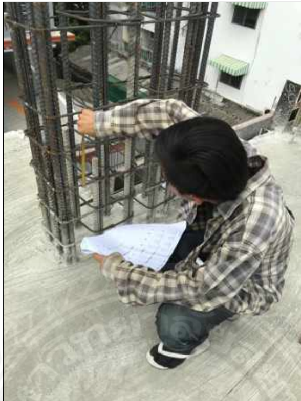
ภาคผนวกรูปที่ 15 ตรวจสอบปลอกเหล็กเสา
