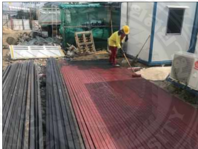
ภาคผนวกรูปที่ 24 ทาสีเหล็กโครงป้าย
