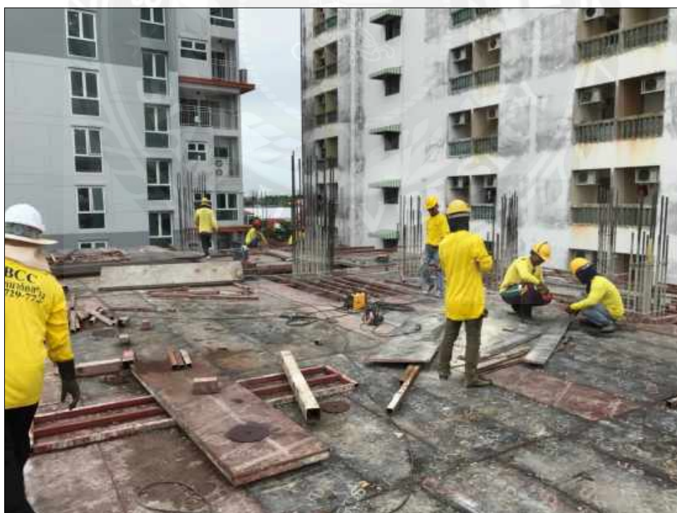
ภาคผนวกรูปที่ 20 เข้าแบบพื้น
