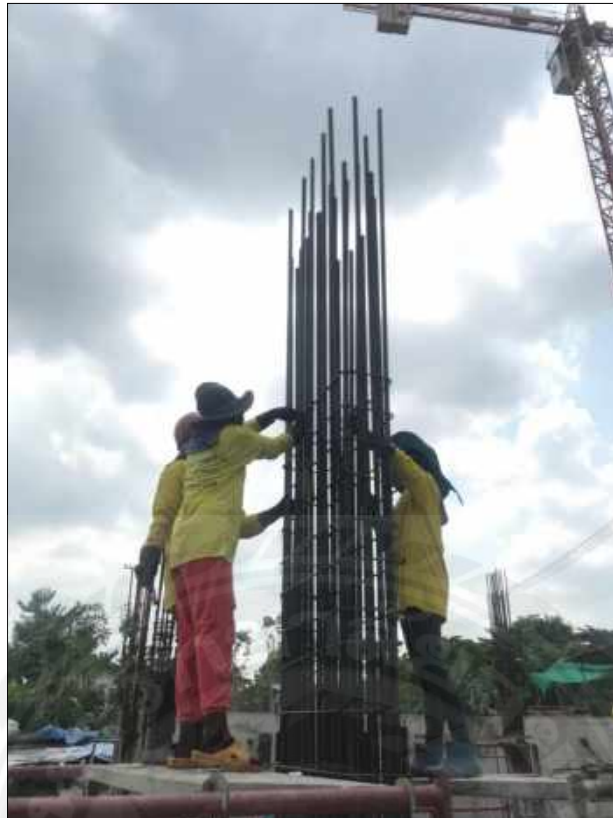
ภาคผนวกรูปที่ 5 ผูกเหล็กเสา
