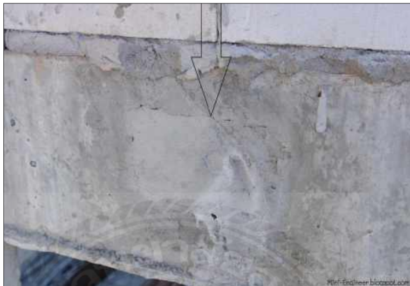
รูปที่ 4.3.31 การอุดปิดเบ้าหลัง Anchorage ด้วยปูนมอร์ตาร์[4]
