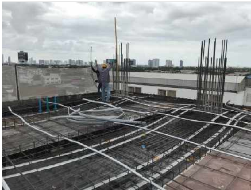
รูปที่ 4.3.9 สอดลวด PC Strand เข้าใน Corrugated sheath (1)[4]
