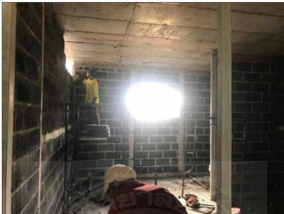
ภาคผนวกรูปที่ 19 ก่ออิฐผนังอาคาร
