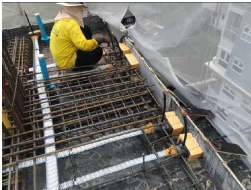
รูปที่ 4.3.15 ติดสมอไซด์ Tendon กับแบบข้างและติดตั้งเหล็กกันระเบิด(3)[4]
