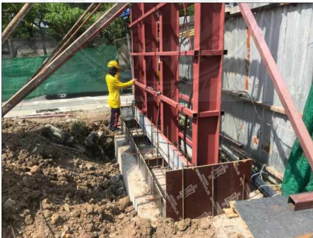
ภาคผนวกรูปที่ 31 เทคอนกรีตฐานป้าย
