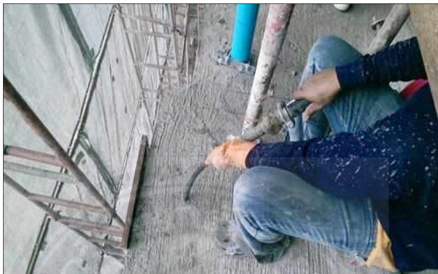
รูปที่ 4.3.33 อัดน้ำปูนเข้าท่อ Grouting(1)[4]
