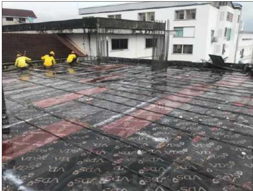
รูปที่ 4.3.7 วางเหล็กเสริมต่าง(2)[4]
