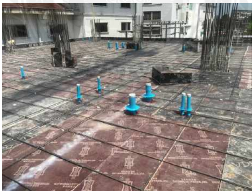
รูปที่ 4.3.6 การวางเหล็กเสริมล่าง(1)[4]
