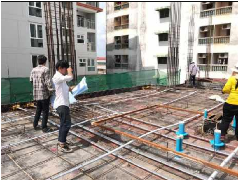
รูปที่ 4.3.21 ตรวจสอบความเรียบร้อยและตรวจสอบความสะอาดก่อนเทคอนกรีต[4]
