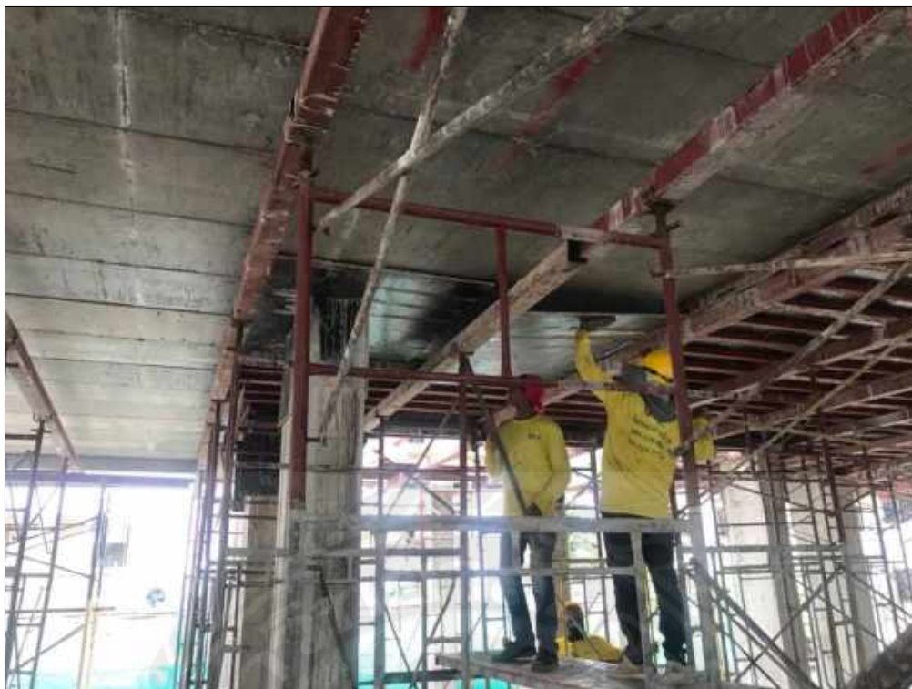
ภาคผนวกรูปที่ 21 ถอดแบบท้องพื้น
