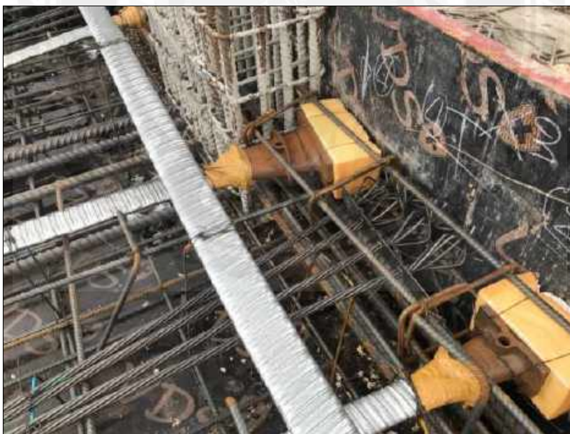
รูปที่ 4.3.12 ติดสมอยึด Tendon กับแบบข้างและติดตั้งเหล็กกันระเบิด[4]
