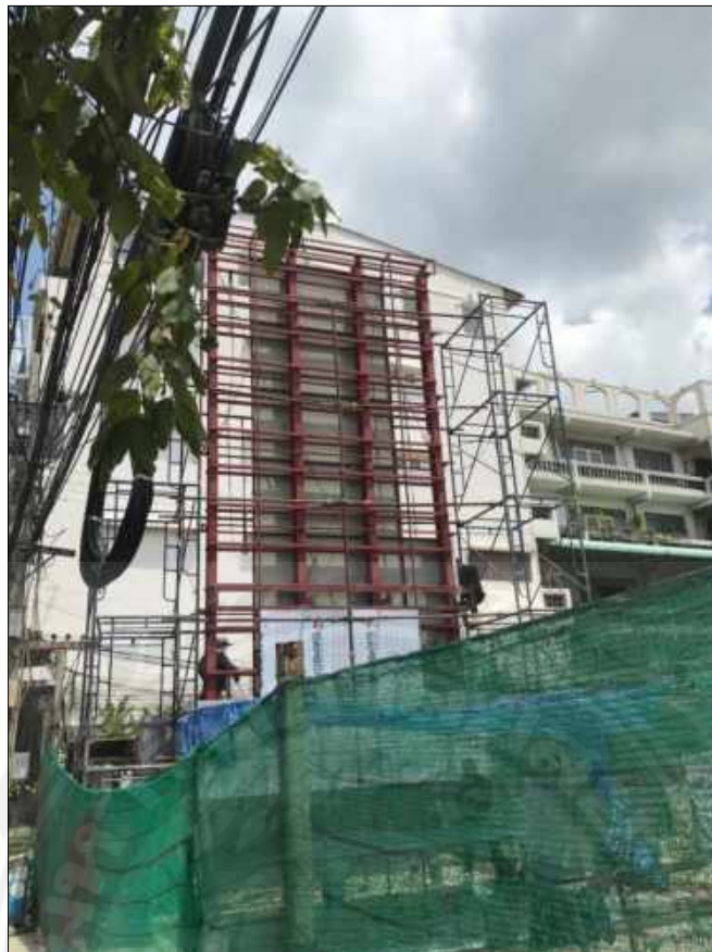
ภาคผนวกรูปที่ 30 เชื่อม โครงข่าย
