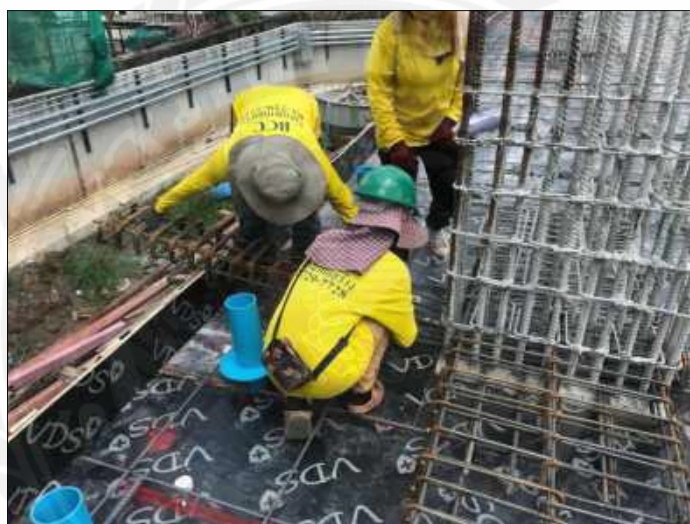
ภาคผนวกรูปที่ 29 ใส่เหล็กเสริมคอสากันแรงเฉือน
