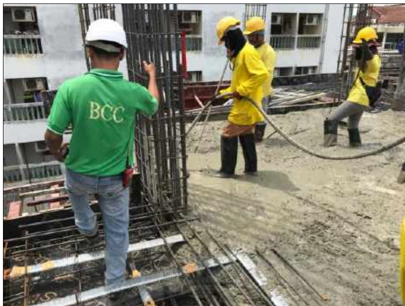
รูปที่ 4.3.25 การเทคอนกรีต(4)[4]
