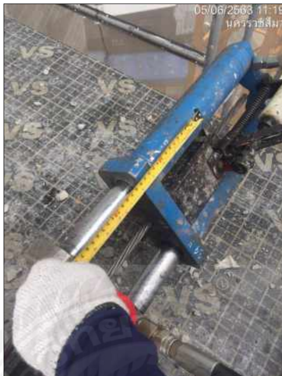
รูปที่ 4.3.29 การดึงลวดอัดแรงคอนกรีต (4) [4]
