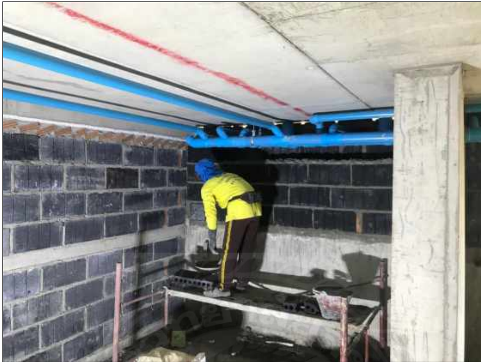
ภาพผนวกรูปที่ 11 ก่ออิฐผนัง
