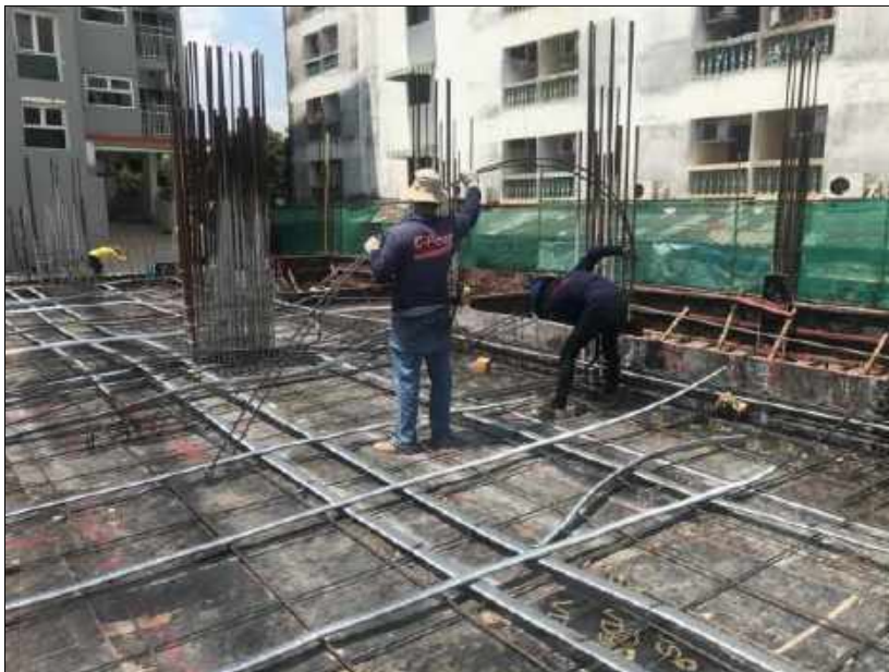
รูปที่ 4.3.11 สอดลวด PC Strand เข้าใน Corrugated sheath(3)[4]
