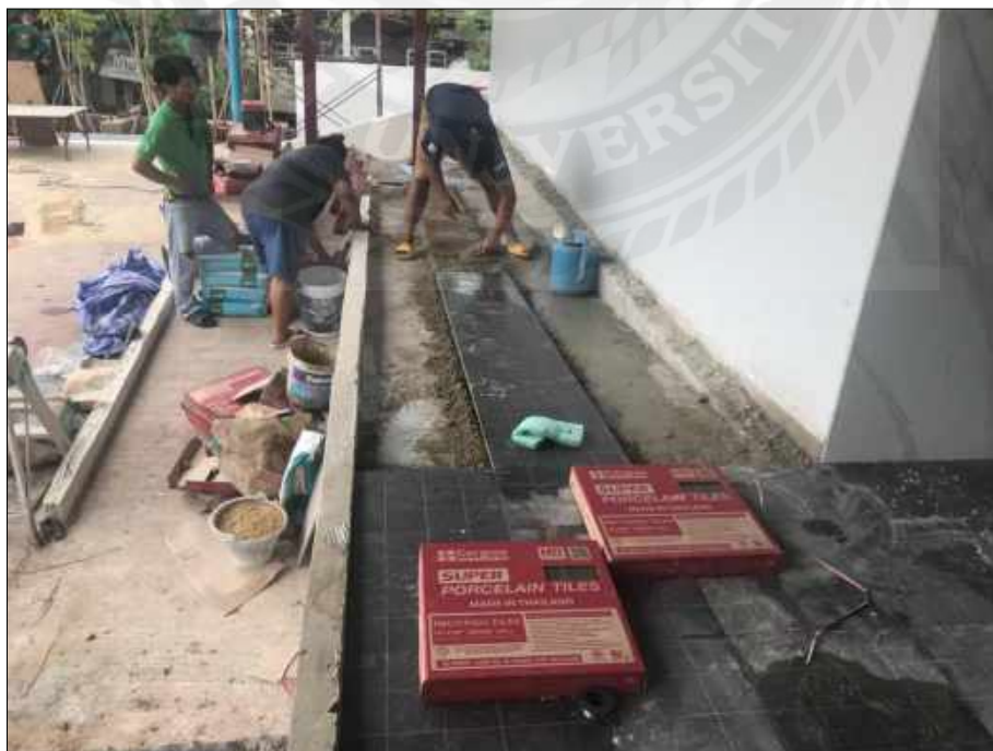
ภาคผนวกรูปที่ 10 ปูกระเบื้อง lamp ทางขึ้น
