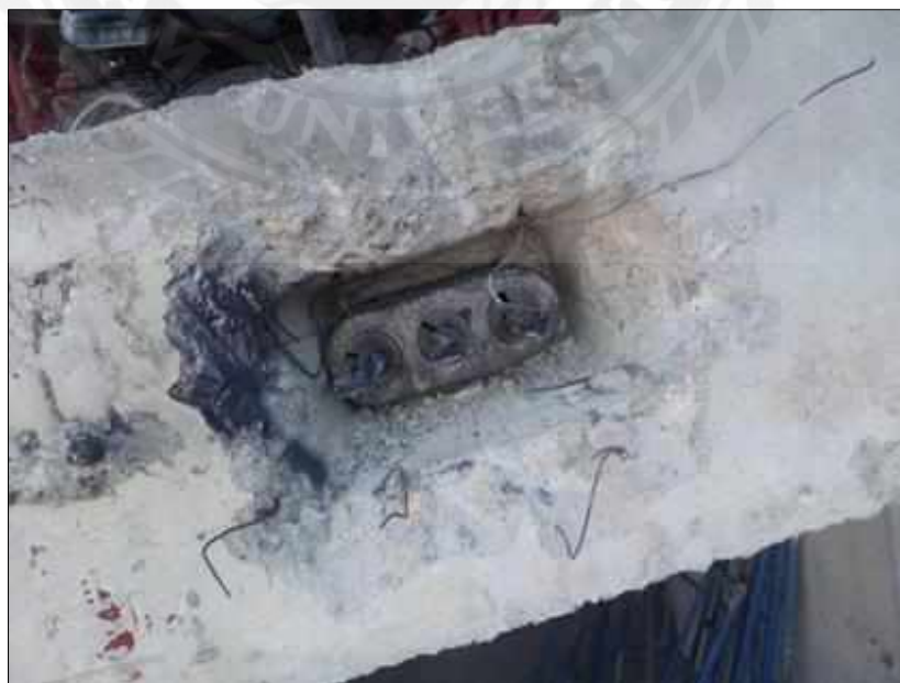
รูปที่ 4.3.30 การตัดหางลวดอัดแรงต้น[4]
