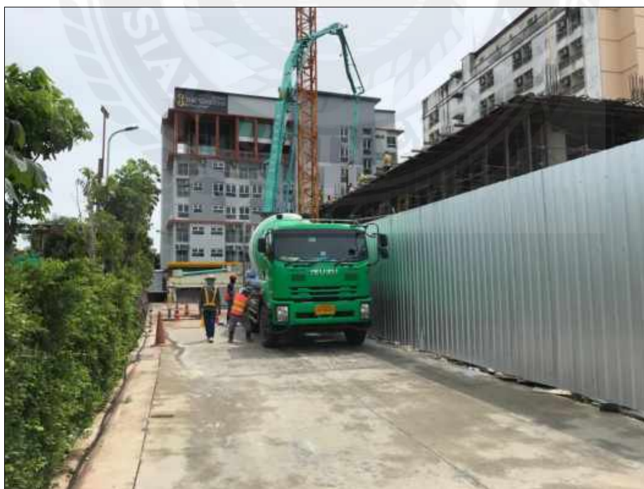
ภาคผนวกรูปที่ 16 รถปูนเข้าเทคอนกรีต
