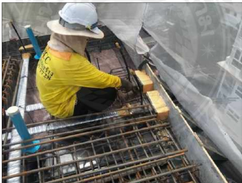
รูปที่ 4.3.14 ติดสมอซีด Tendon กับแบบข้างและติดตั้งเหล็กกันระเบิด(2)[4]
