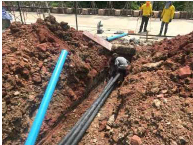
ภาคผนวกรูปที่ 23 ฟังท่อน้ำเข้าอาคาร
