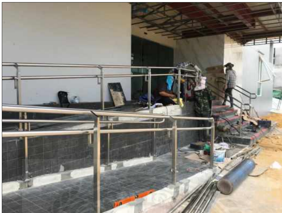
ภาคผนวกรูปที่ 17 ติดตั้งราวสแตนเลส lamp ทางขึ้น
