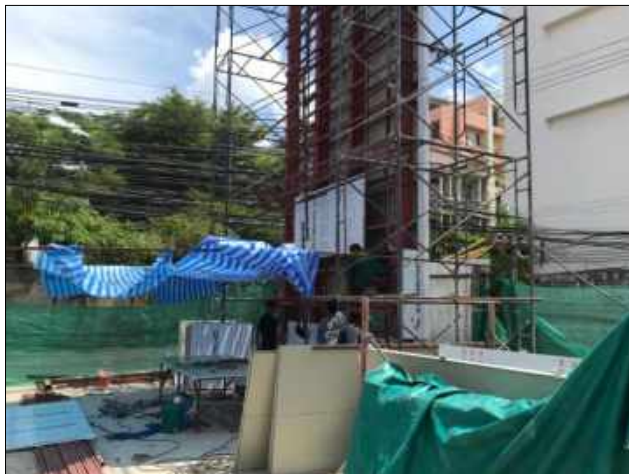
ภาคผนวกรูปที่ 28 เชื่อมโครงป้าย
