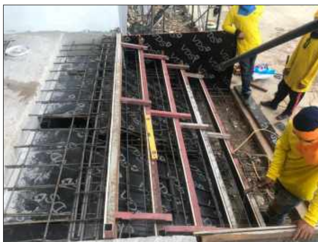
ภาคผนวกรูปที่ 26 เข้าแบบบันไดหน้าอาคาร
