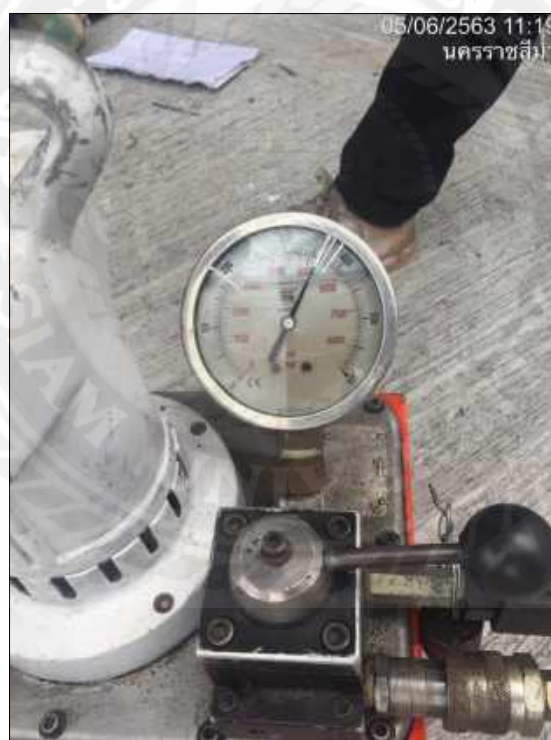
รูปที่ 4.3.28 การดิ่งลาวอัดแรงคอนกรีต(3)[4]
