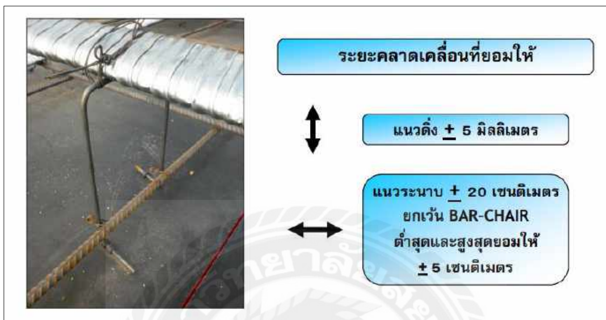
รูปที่ 4.2.6 การติดตั้ง Bar chair[1]
