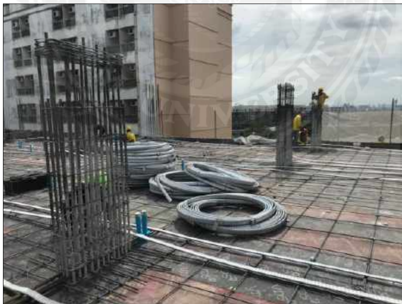
รูปที่ 4.3.8 สอดลวด PC Strand เข้าใน Corrugated sheath[4]
