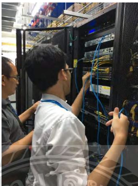
รูปที่ 5 การติดตั้งสายสัญญาณของระบบเครือข่าย
