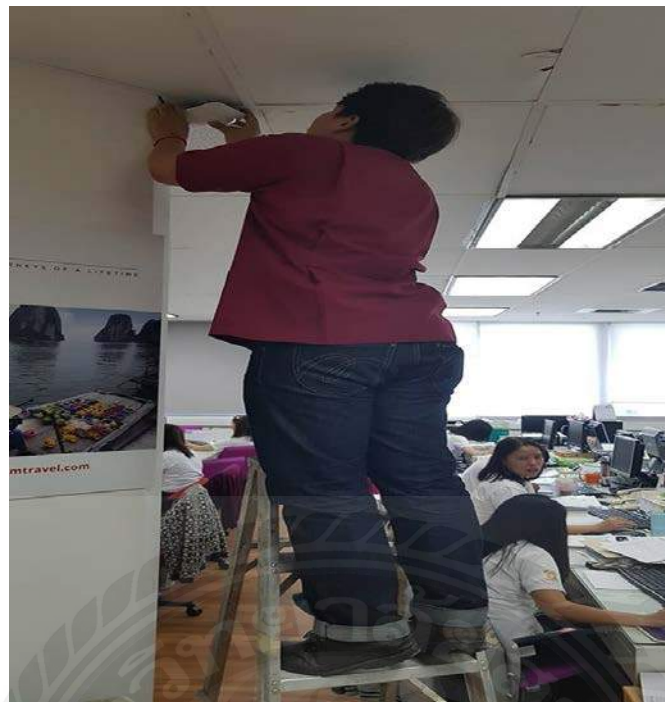
รูปที่ 4.7 การติดตั้ง Access Point IT
