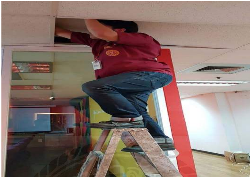
รูปที่ 4.5 การเดินสายแลนไปยังจุดต่าง ๆ
