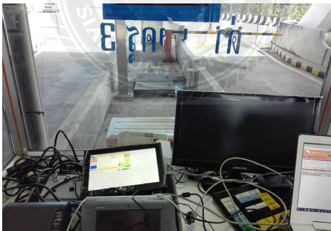
รูปที่ ก.1 ขณะปฏิบัติงานติดตั้งระบบ2
