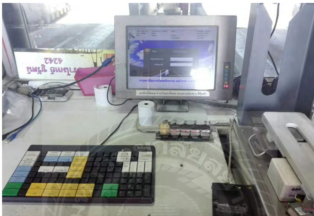
รูปที่ ก.1 ขณะปฏิบัติงานติดตั้งระบบ1
