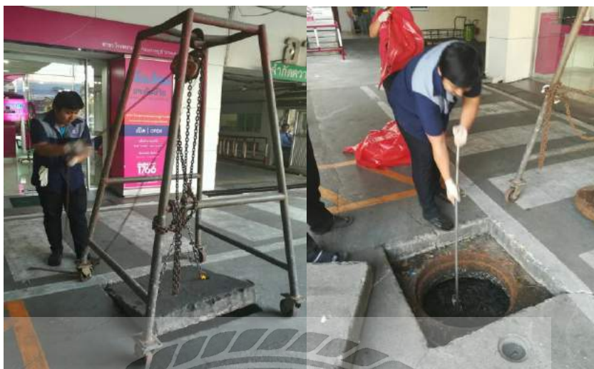
รูปที่ 3.10 การตัดตะกอนบริเวณด้านหน้าตะแกรงก่อนเข้าสู่บ่อเกรอะ
