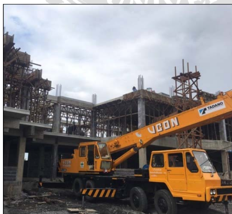
รูปที่ 4.11 เข้าสู่กระบวนการติดตั้งโดยใช้รถเครนและแรงงานคน
