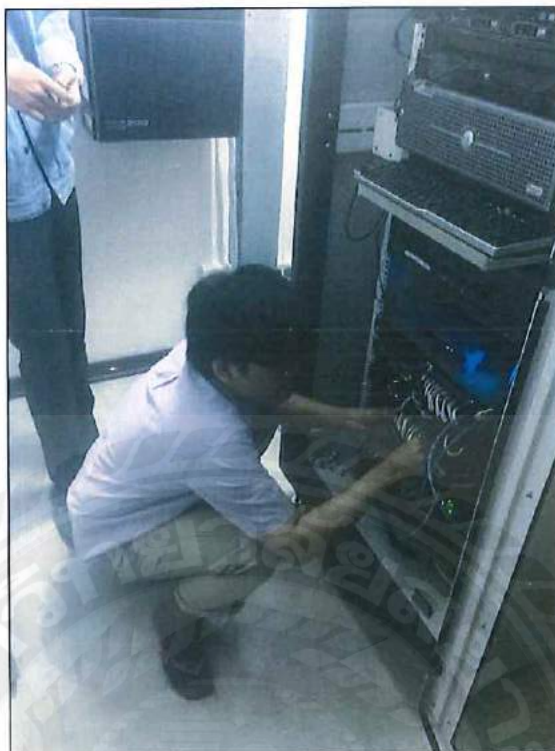
รูปที่ ก.1 การติดตั้งสาย LAN สำหรับเชื่อมต่อกับ Access point
